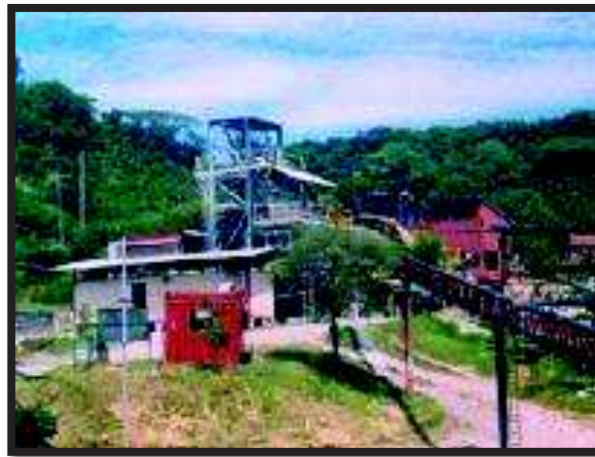
Gráfico N° 2.3: Vista panorámica de la Planta de Lixiviación
