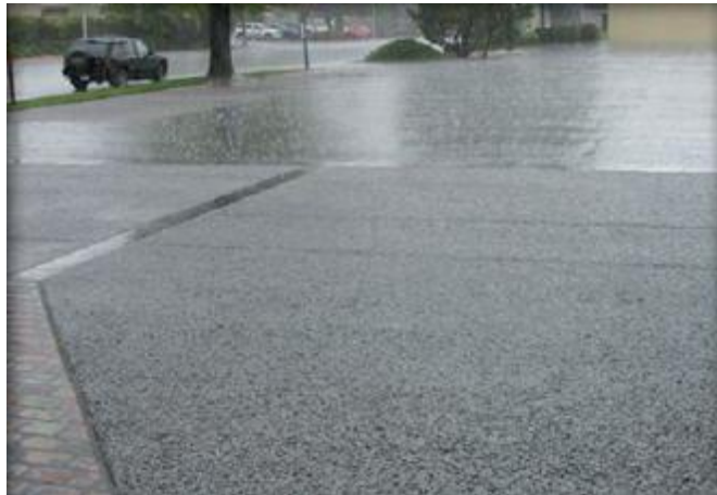
Ilustración 7. Influencia de la precipitación en el pavimento permeable
