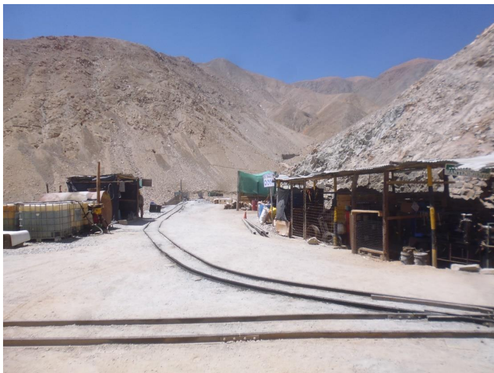
Fotografía N° 14: Trabajos en superficie mina Las Bravas N° 2
