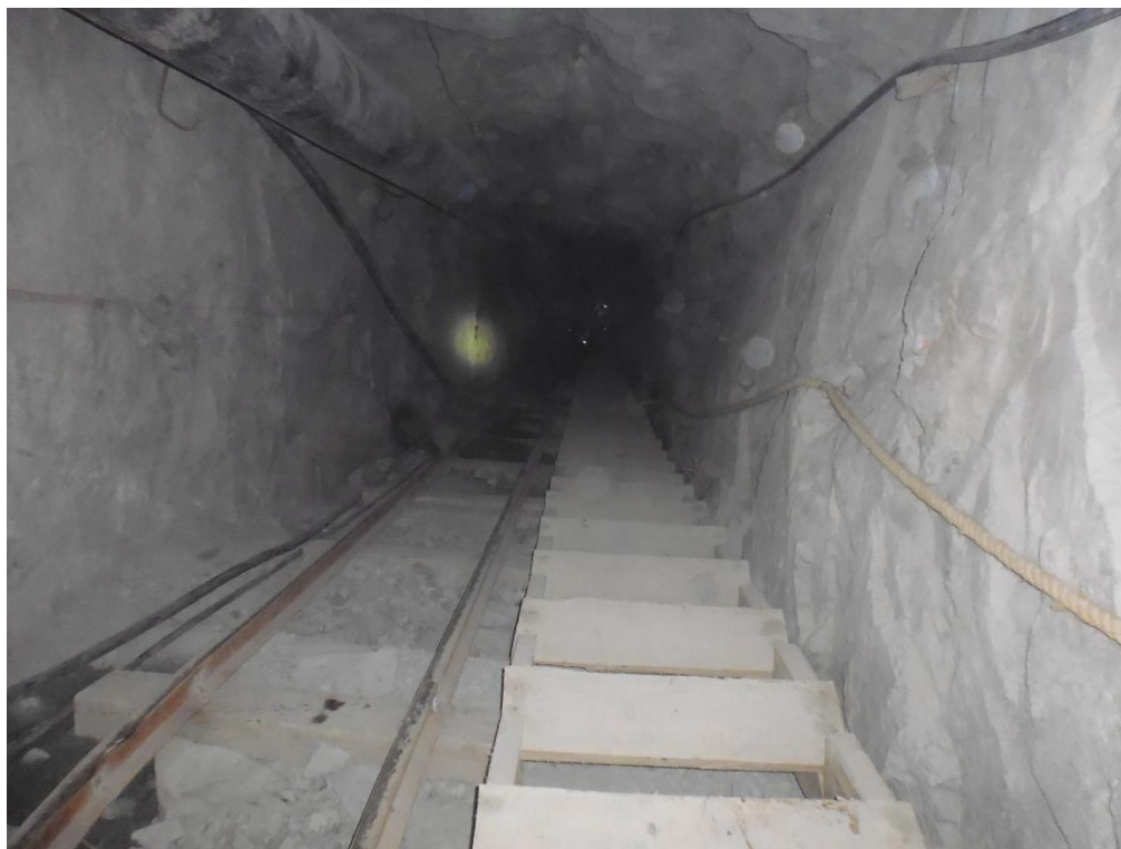
Fotografía N° 13: Labores en la mina Las Bravas N° 2
