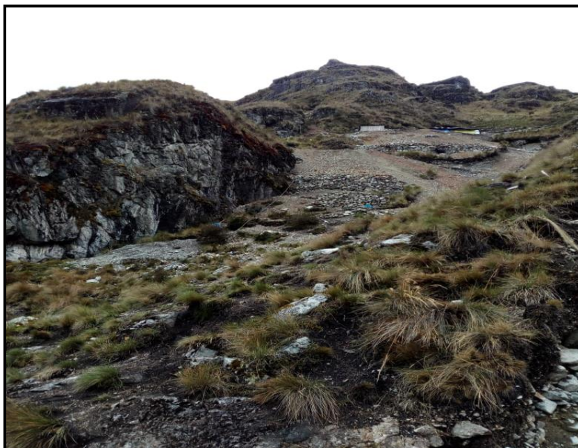
Imagen N° 03: Presencia de Desmonte en el Cerro Syrupata
