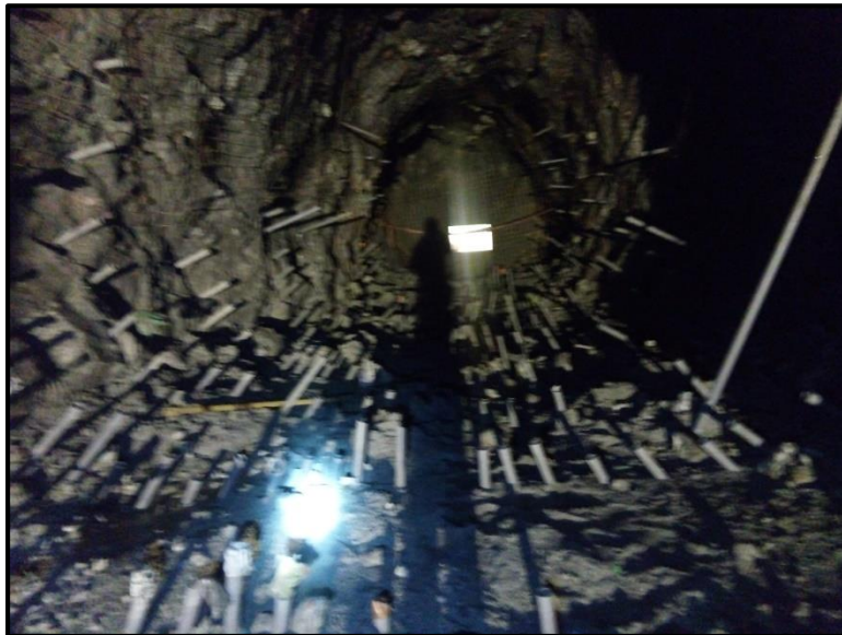
Fotografía 04. Entubado de los taladros para evitar que se tapen
