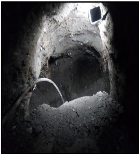
Fotografía 06. Tj.175 en proceso de relleno hidráulico
