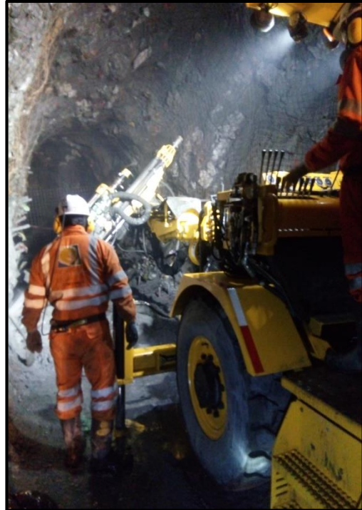
Fotografía 03. Aumulacion de taladros en negativos con equipo Raptor 55
