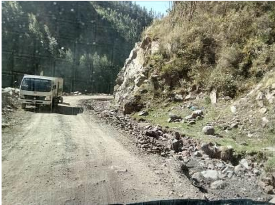
Foto No 34 Área peligro bajo, producto de deslizamiento con presencia de material coluvial. – Fundición
