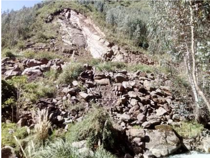
Foto No. 4 Deslizamiento semi profundo, zona de Fundición – Ruta a Pallanchacra
