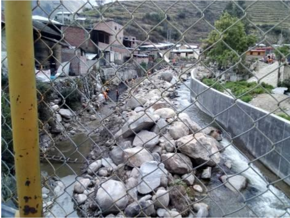
Foto No 39 Construcción de ambos muros ribereños, en el río Paucartambo.
