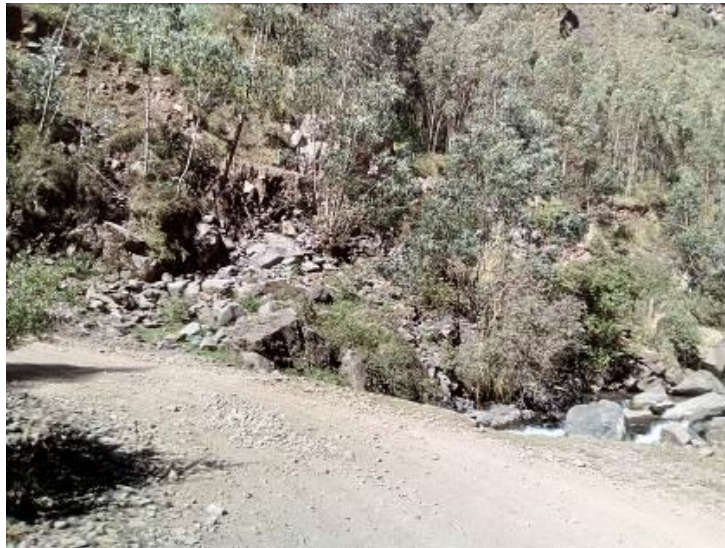
Foto No 3 Riesgo hidrogeológico con evidencias de flujo de material – Pallanchara
