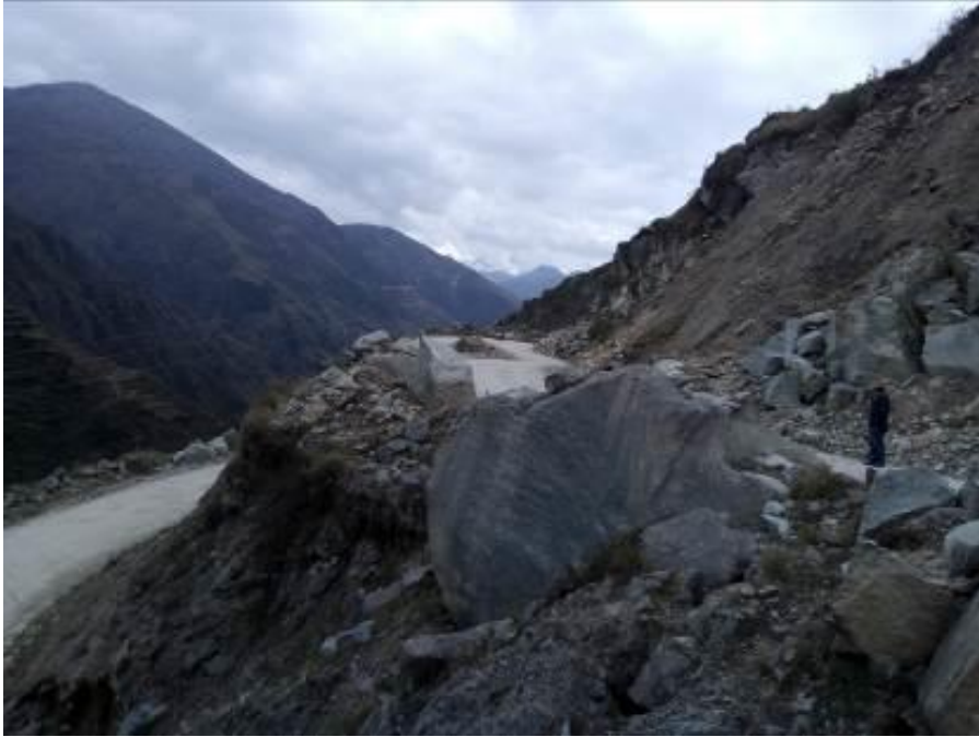
Foto No 33 Área peligro alto, producto de fuerte, presencia de fracturas abiertas y diaclasas – Paucartambo
