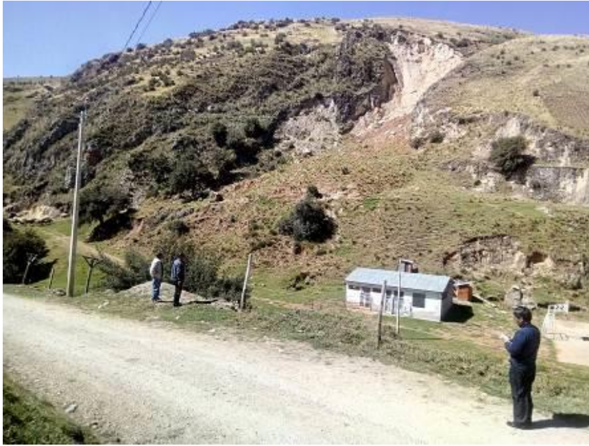
Foto No 15 Deslizamiento de suelo semi profundo – Pariamarca.
