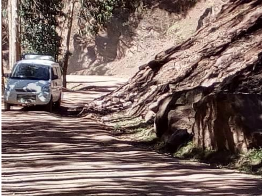
Foto No 17 Deslizamiento de suelo semi profundo – Pachacrahuay.
