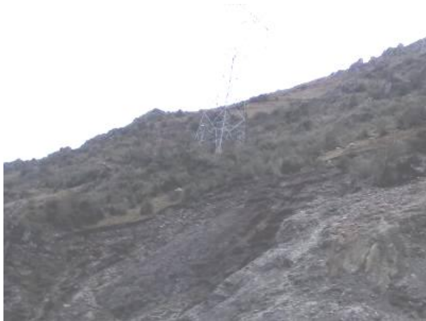
Foto No 23 Deslizamiento de suelo semi profundo con desprendimiento de grandes de material morrenico por la acción del hombre poniendo en peligro a otro recurso eléctrico – Paucartambo
