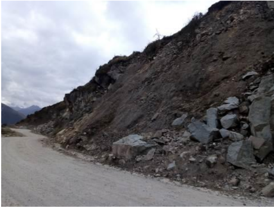
Foto No 38 Rocas caídas por la construcción de la carretera a Paucartambo.
