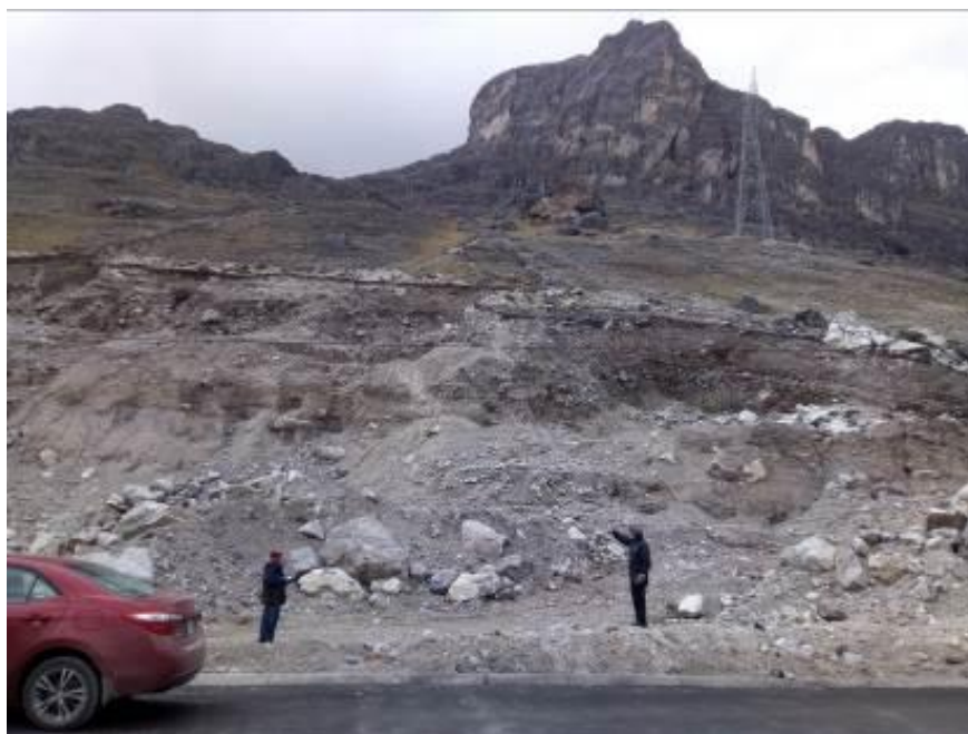
Foto No 24 Deslizamiento de suelo semi profundo con desprendimiento de grandes rocas de material morrenico por la acción del hombre poniendo sin ningún control – Paucartambo
