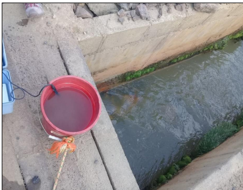
Detalle del canal del efluente doméstico para el recojo, al costado la medición instantánea de parámetros de campo.
