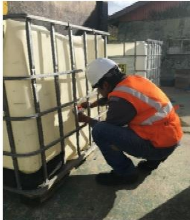
Ilustración 19. Instalación de válvula lateral de drenaje.
