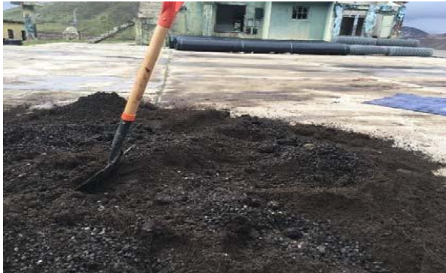
Ilustración 16. Proceso de elaboración del top soil: mezcla tierra y guano de ovino.
