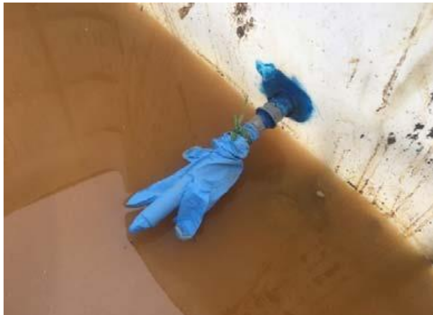
Ilustración 22. Protección del tubo PVC durante el llenado de barril
