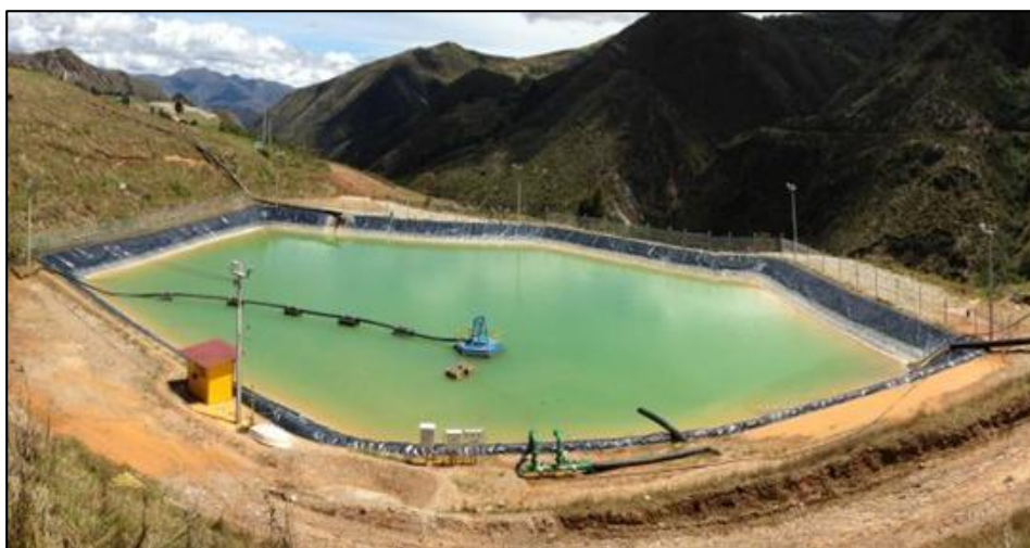
Figura N° 4.2: Solución clarificada – Poza Clarificadora de capacidad 10000 m 3 .
