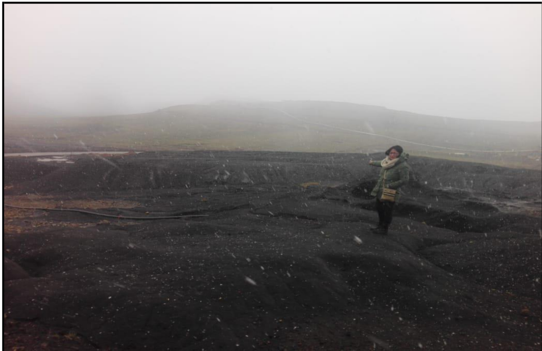
IMAGEN N° 01: PASIVO AMBIENTAL- CANCHAS DE DESMONTE - EX FUNDICION TINYAHUARCO-DISTRITO DE TINYAHUARCO
