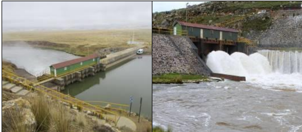
Fotografía 19. La represa Upamayo ubicado al oeste del lago Chinchaycocha es la que regula la salida de las aguas, para la generación de energía hidroeléctrica por las empresas encargadas de su administración.
