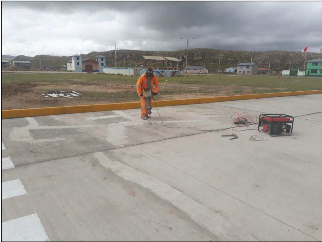
Demolición de Pavimentos con Fisuras
