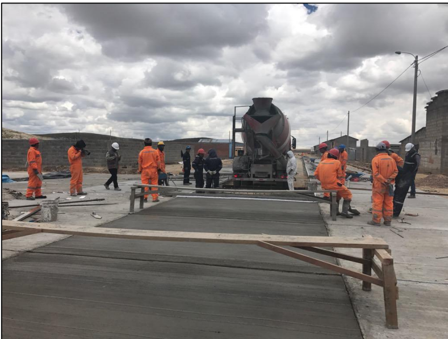
Vertido de Concreto Masivo
