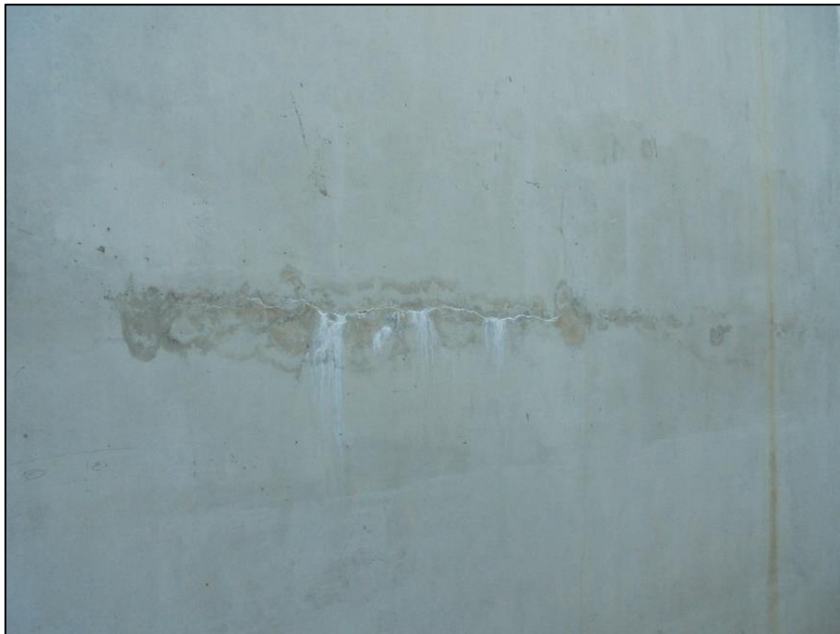
Evidencia del tratamiento de fisuras en tanques de la planta de tratamiento de aguas residuales del centro penitenciario.
