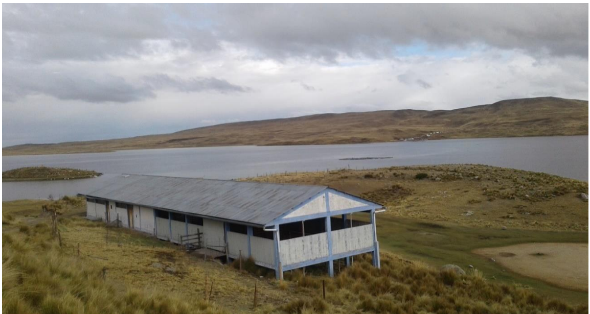
Foto 06 construcción cerca de la laguna de Punrun
