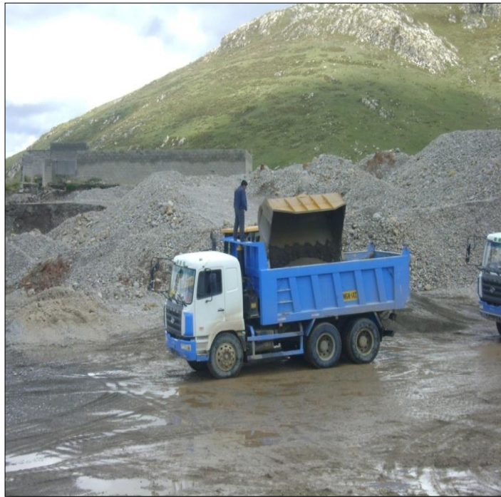
Ilustración 10. Extracción de hormigón de segundo lavado de cant. Sacrafamilia mediante maquinaria pesada Fuente: Propio
