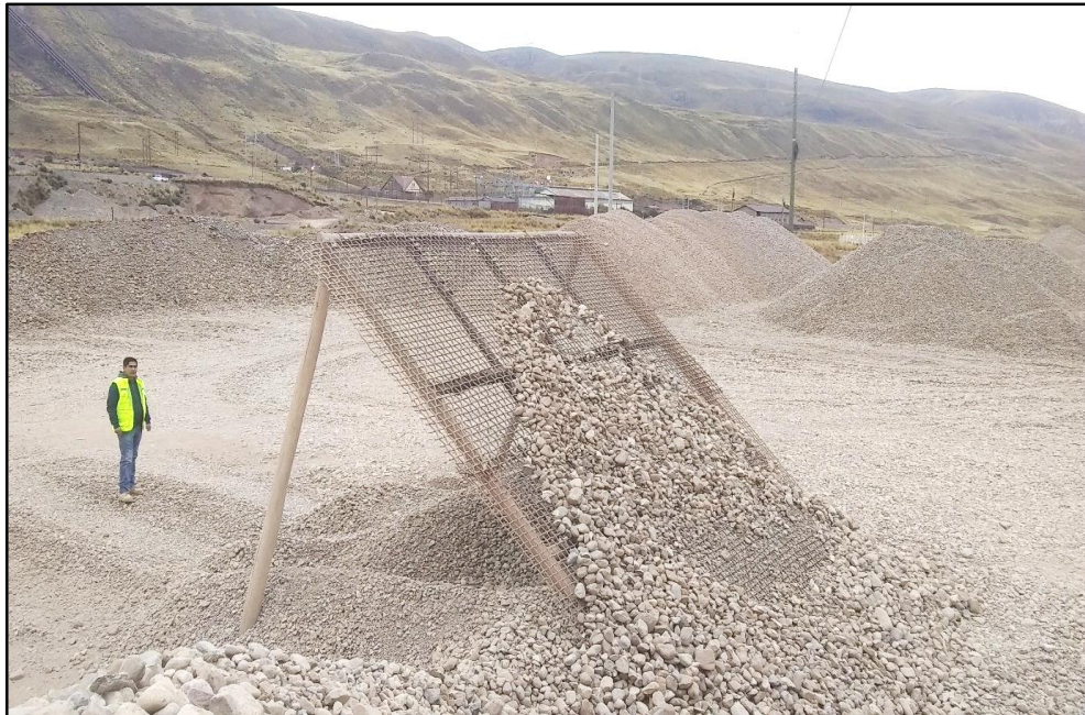
Figura 4-4 Zaranda metálica para la clasificación de los agregados – cantera Roma.
