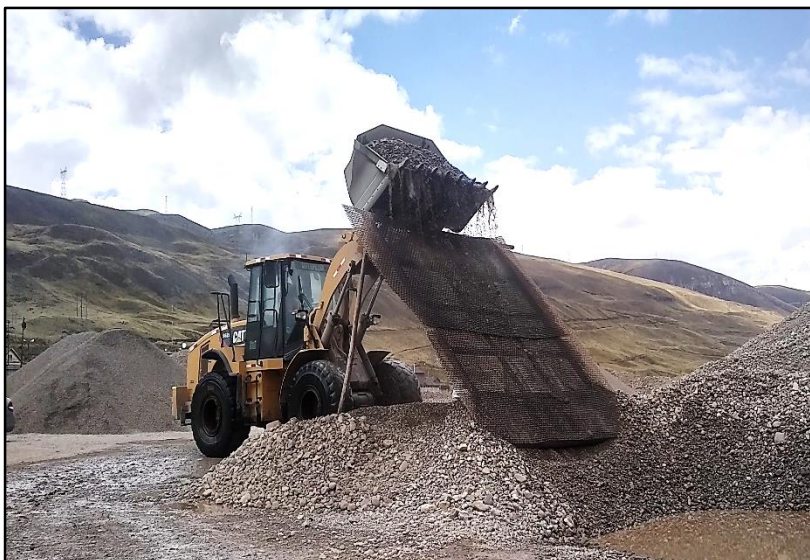
Figura 3-1 Proceso mecanizado en la extracción de agregados.
