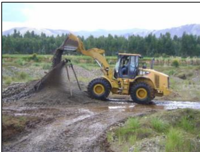
Figura 2-4 Extracción de Cantera de Aluvión.
