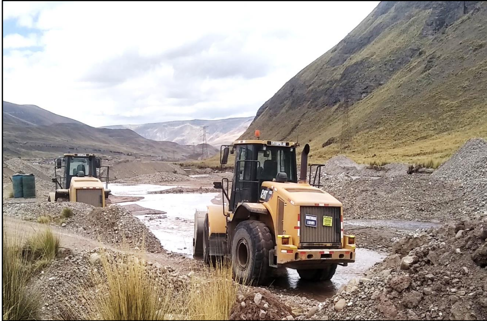
Figura 4-7 Explotación a cielo abierto con cargador frontal - cantera Pachachaca.
