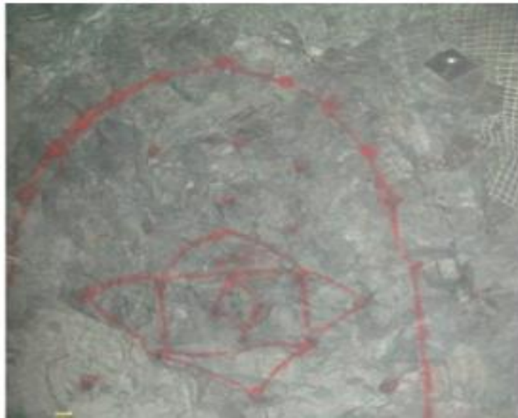
Fig. N° 03 malla de perforación Dato de campo
