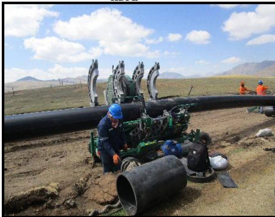
Figura 18. Trabajos realizados – Suministro e instalación de tubería HDPE
