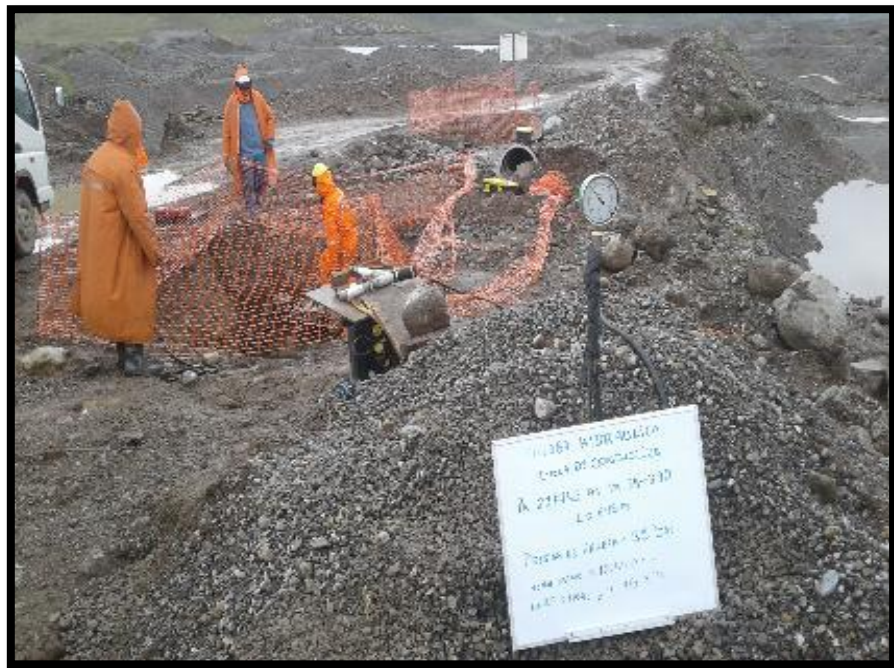
Figura 20. Trabajos realizados – Pruebas Hidráulicas
