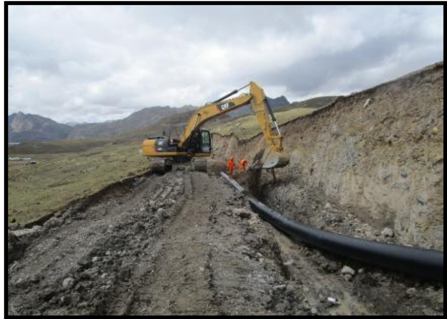
Figura 16. Trabajos realizados – Relleno de zanjas
