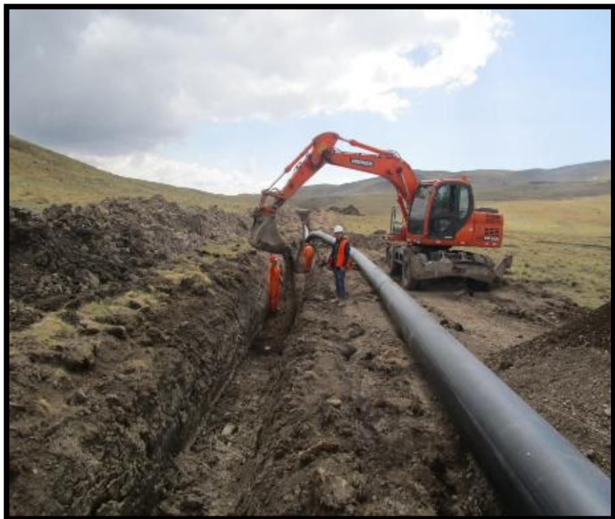
Figura 15. Trabajos realizados – Excavación de zanjas
