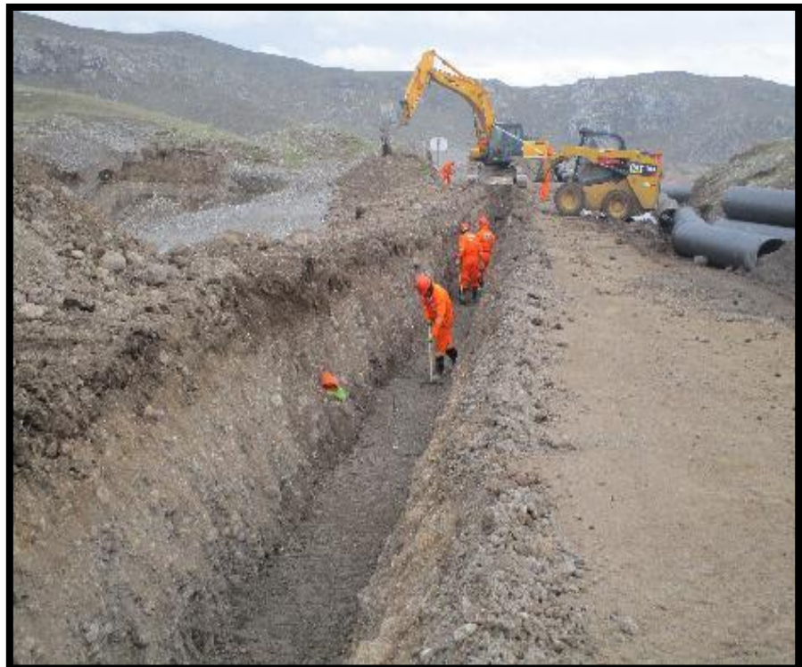
Figura 17. Trabajos realizados – Cama de grava de arena
