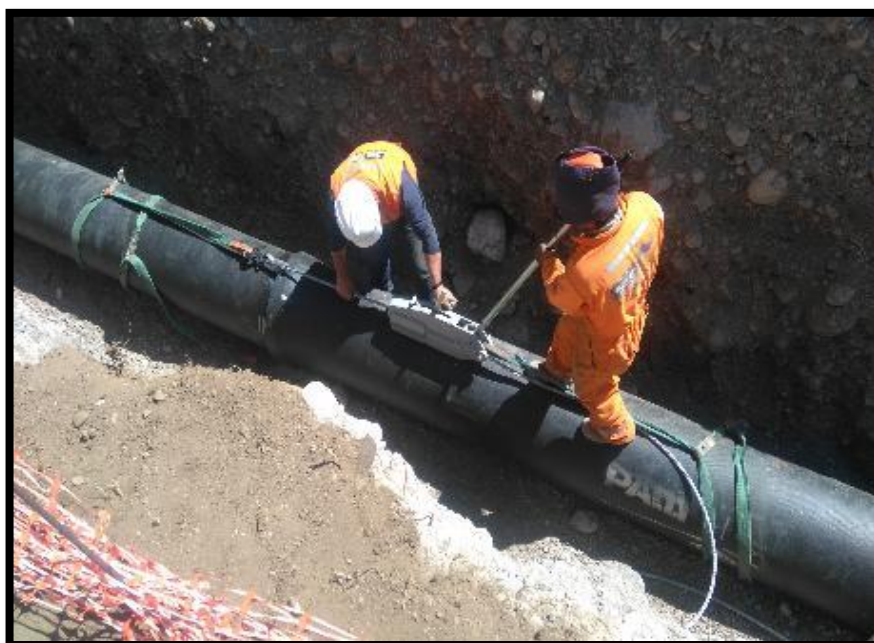
Figura 19. Trabajos realizados – Suministro e instalación de tubería HD
