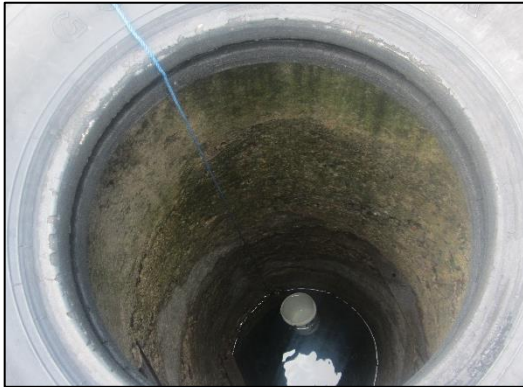
Fotografía 11. Vista interior de pozo artesanal Pozo muestreado N° 1
