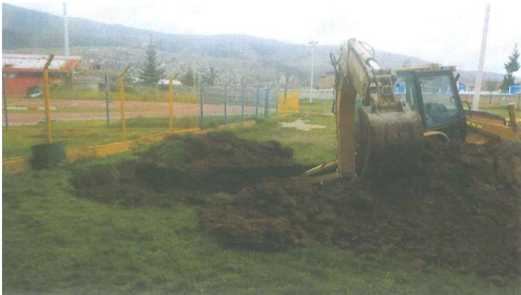
Fotografía 4: vista de la calicata N° 02 con profundidad de 6 m. UTM 478007 m. E y 8665331 m. N
