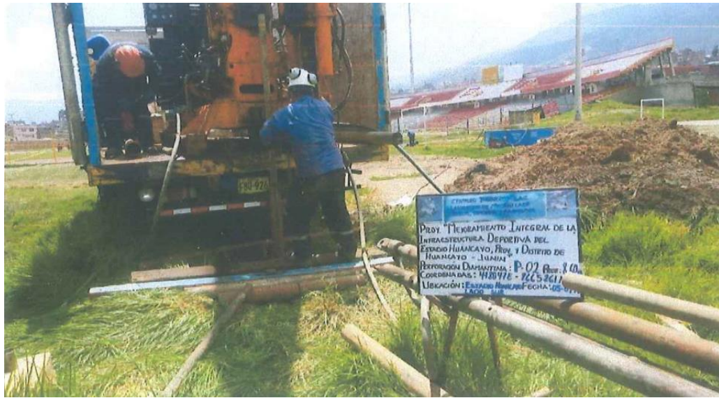
Fotografía 11: vista de la perforación diamantina con profundidad de 16 m. UTM 478047 m. E y 8665261 m. N
