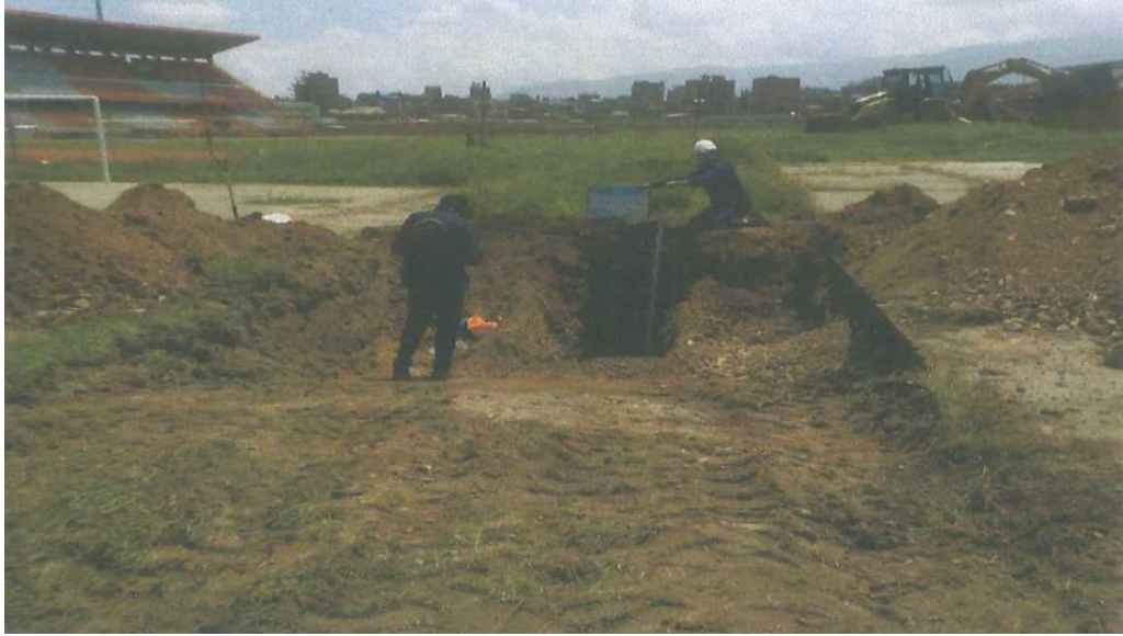
Fotografía 9: vista de la calicata N° 07 con profundidad de 6 m. UTM 478055 m. E y 8665274 m. N
