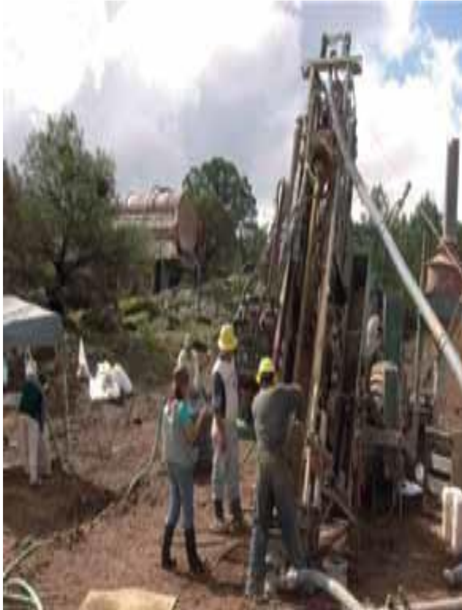
Figura 4. Maquinaria utilizada en la perforación durante la exploración.
