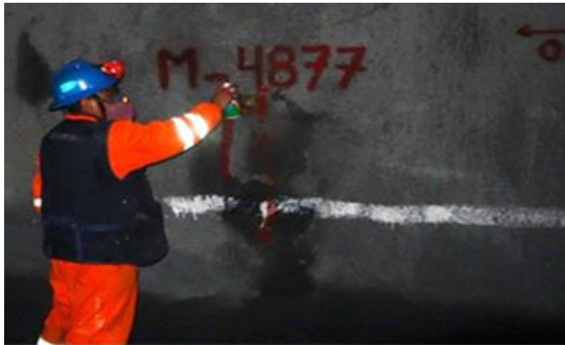
Fig. 2.9. Marcado de la ubicación del canal.
