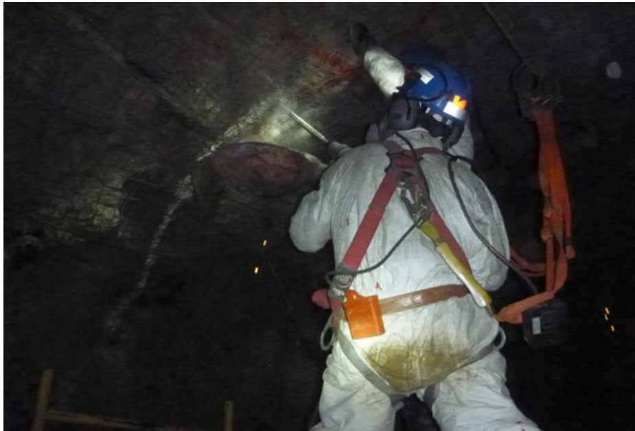
Fig. 2.11. Muestreo mecanizado con el uso del Taladro BOSCH GBH11.
