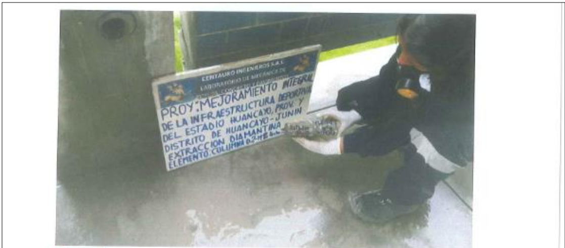
FOTOGRAFIA 4: Vista de la extracción de diamantina columna D2-M2, tribuna oriente para el proyecto.
