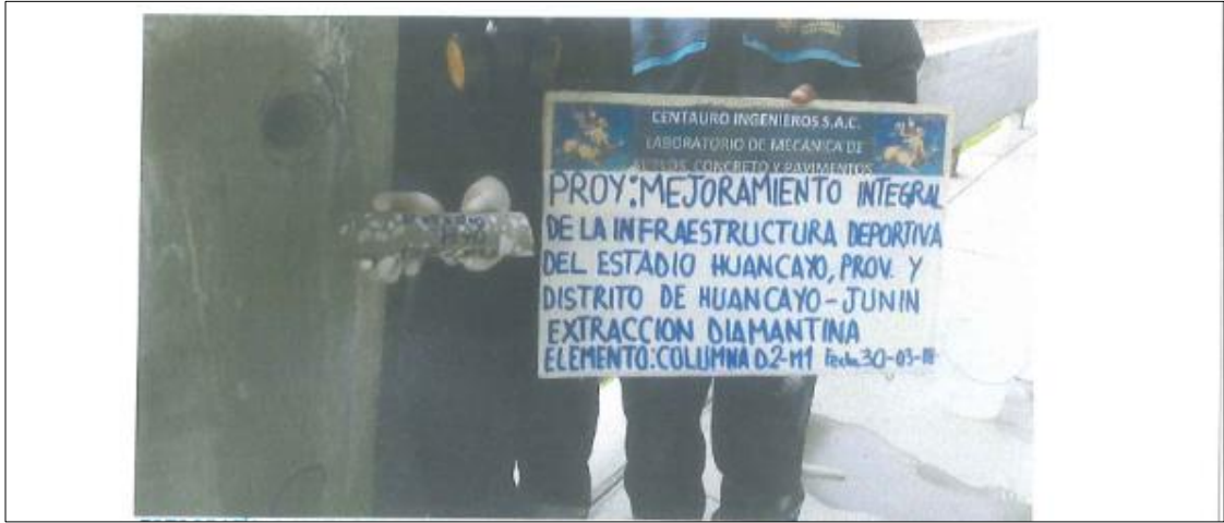
FOTOGRAFIA 1: Vista de la extracción de diamantina columna D2-M1 Tribuna Oriente para el proyecto.
