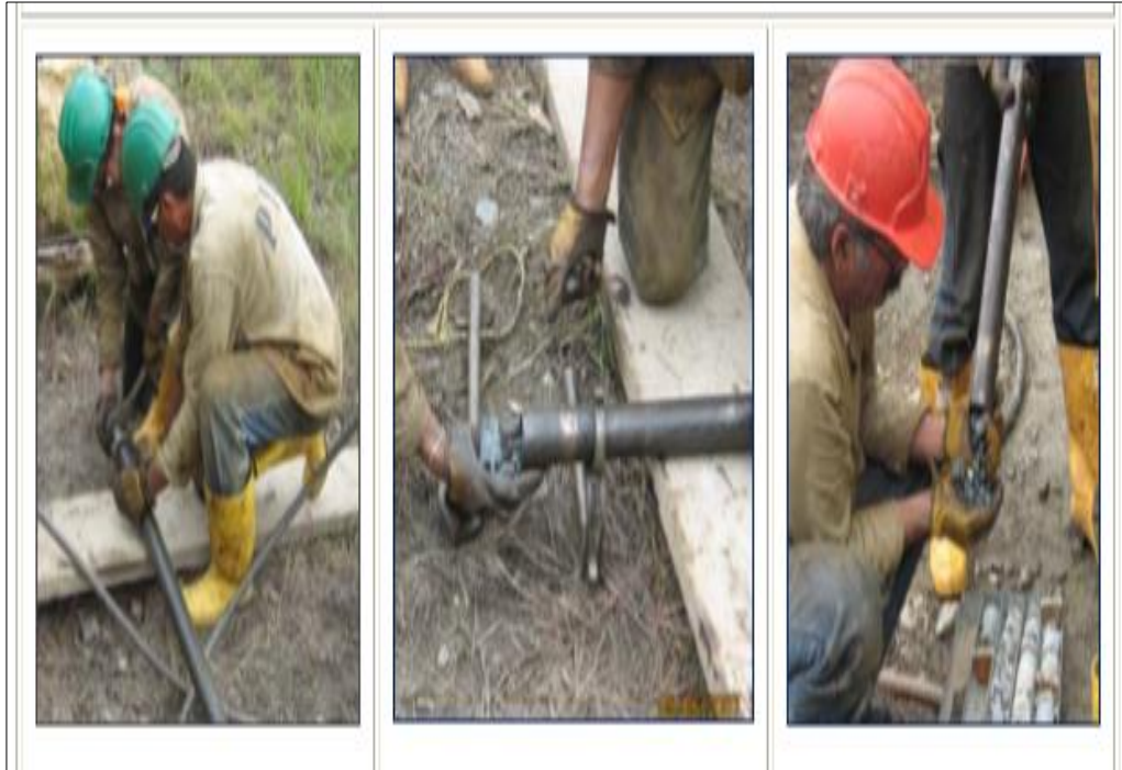
FIGURA 5. Recuperacion de nucleo de roca usando perforación a rotacion.
