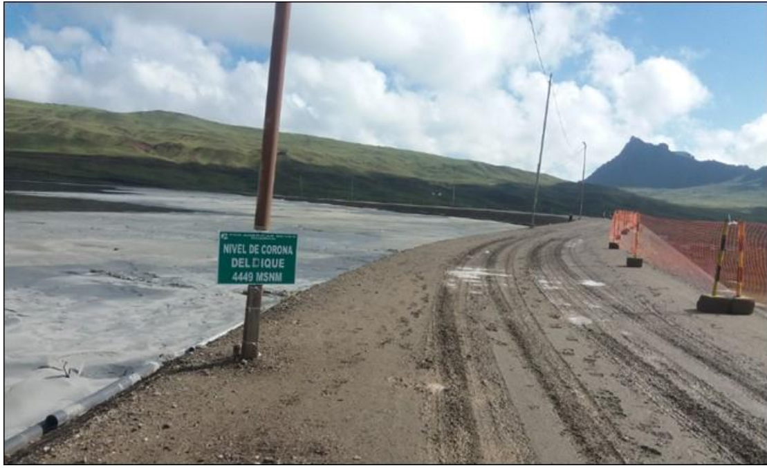
Fig. 18 – Corona existente de Presa de Relaves N°05 – Postes en funcionamiento
