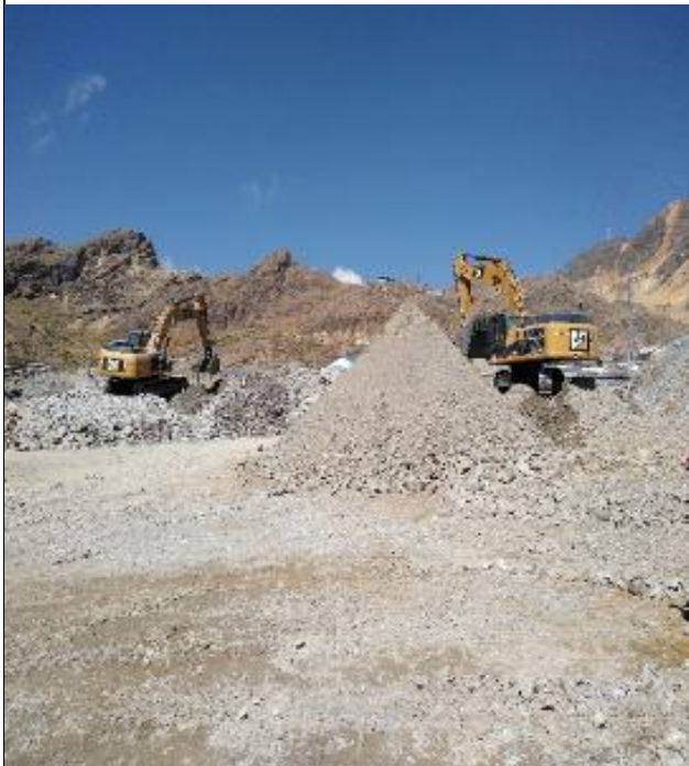
Foto N° 3: Preparación de material en Cantera San Narciso
