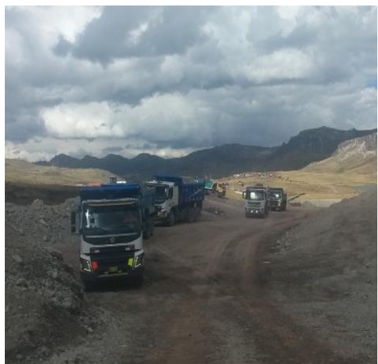
Foto N°02: Transporte de material desde san Narciso hacia espaldón de Presa de Relaves N° 05
