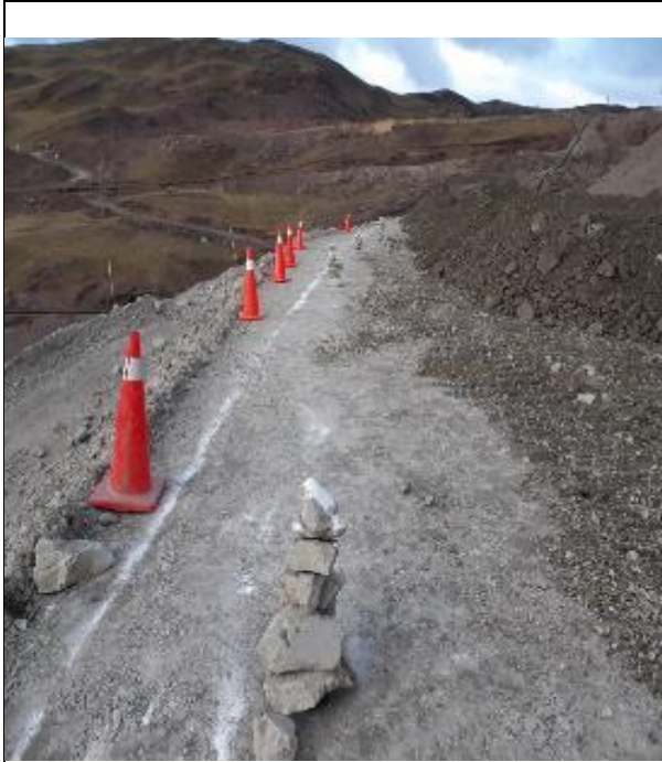
Foto N° 03: Trazo topográfico en espaldón de Presa
