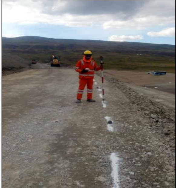
Foto N° 02: Trazo topográfico de Hombro en Espaldón de Presa
