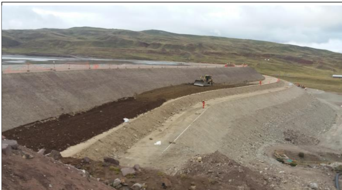
Foto N° 01: Conformación de material estructural el espaldón de Presa de Relaves
