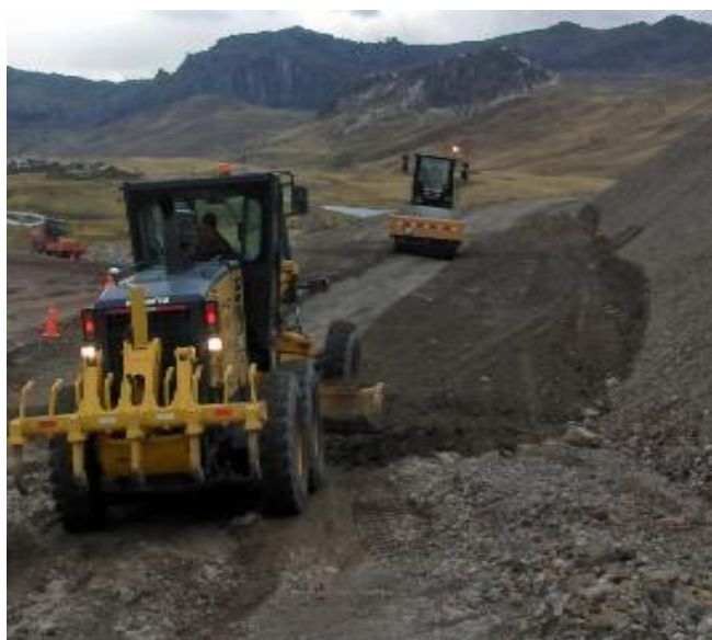
Foto N° 02: Conformación de material estructural en Presa de Relaves
