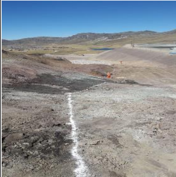
Foto N° 01: Trazo topográfico estribo Norte
