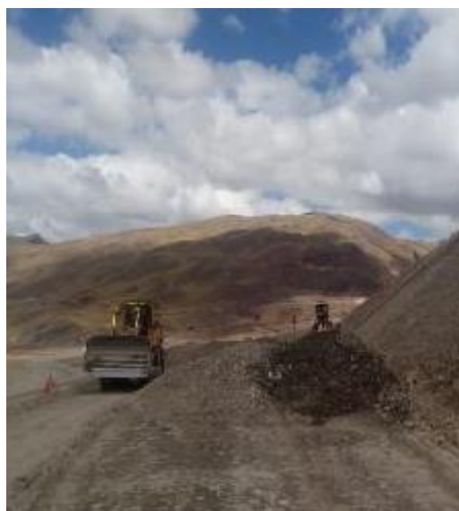
Foto N° 03: Conformación de material estructural en Presa de Relaves
