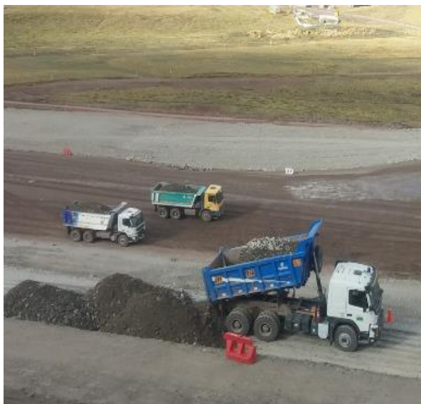
Foto N° 01: Transporte de material desde san Narciso hacia espaldón de Presa de Relaves N° 05
