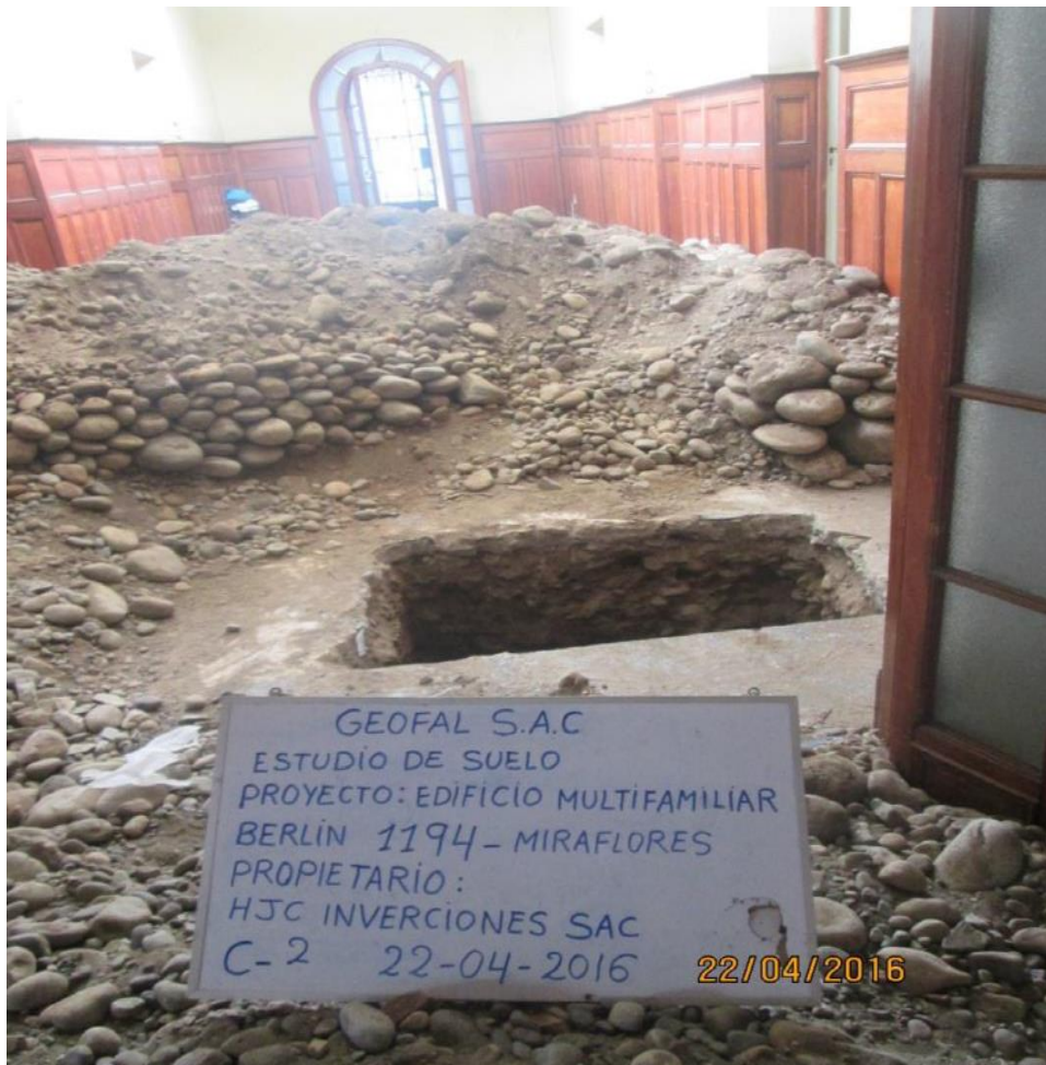
IMAGEN Nº 07-08: UBICACIÓN DE LA CALICATA "C2, MIRAFLORES, LIMA.
