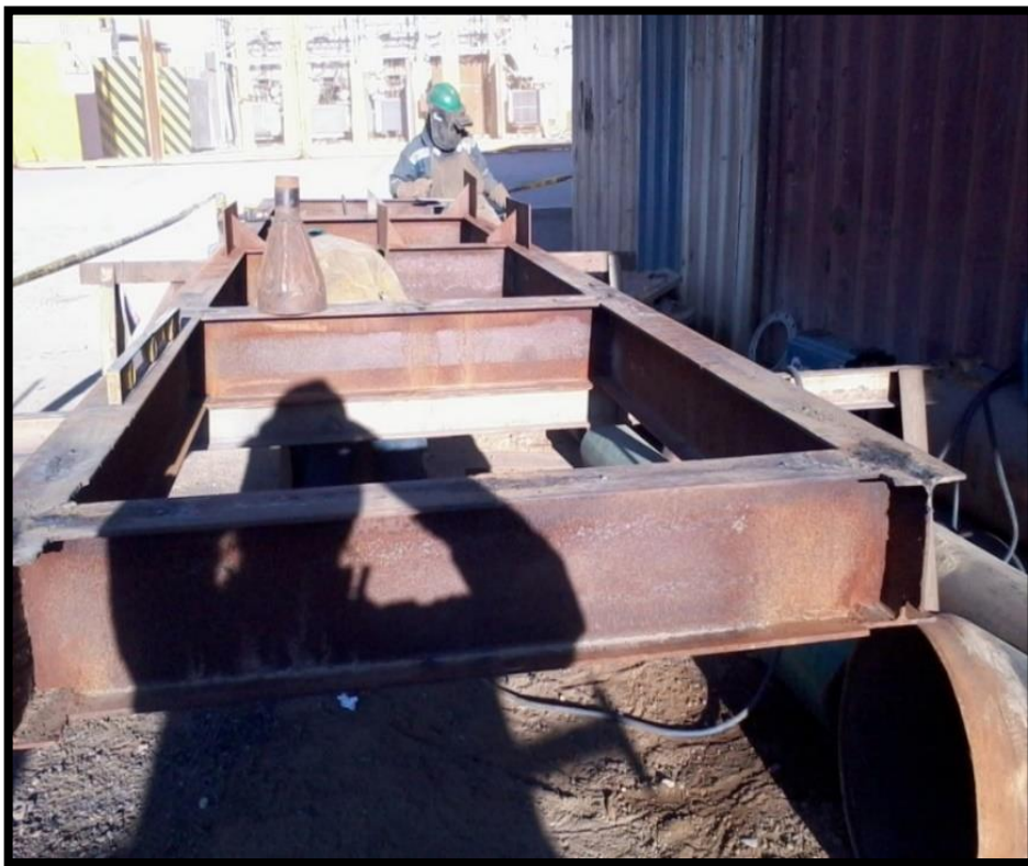
Figura N° 3.5: Plataforma para recibir tanques
