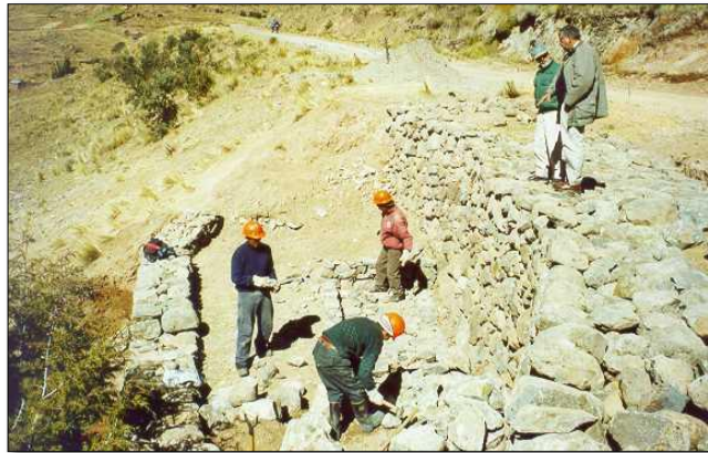
Ilustración 7. Muro en mampostería de piedra
