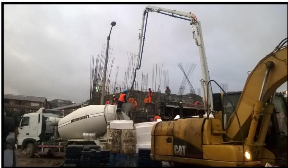
**BASEADO DE LAS COLUMNAS Y LOSA DE CONCRETO ARMADO – CON MIXER**
