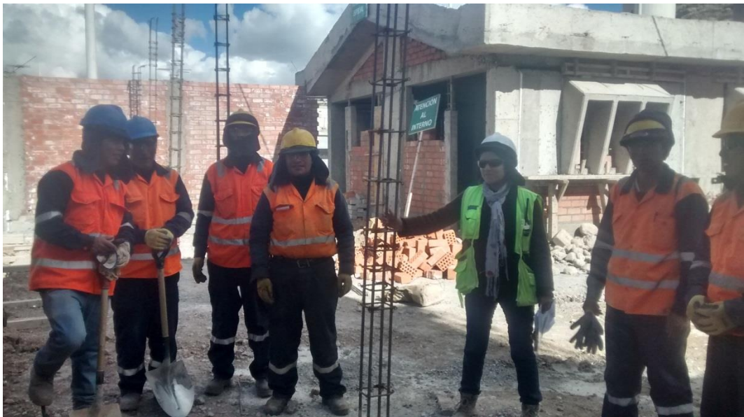
FOTO N°01.- charla de seguridad antes de iniciar las labores de trabajo.
