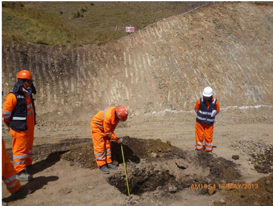
FOTO N°02.- Supervisando el cumplimiento de los EPP en los trabajos que se vienen desarrollando.
