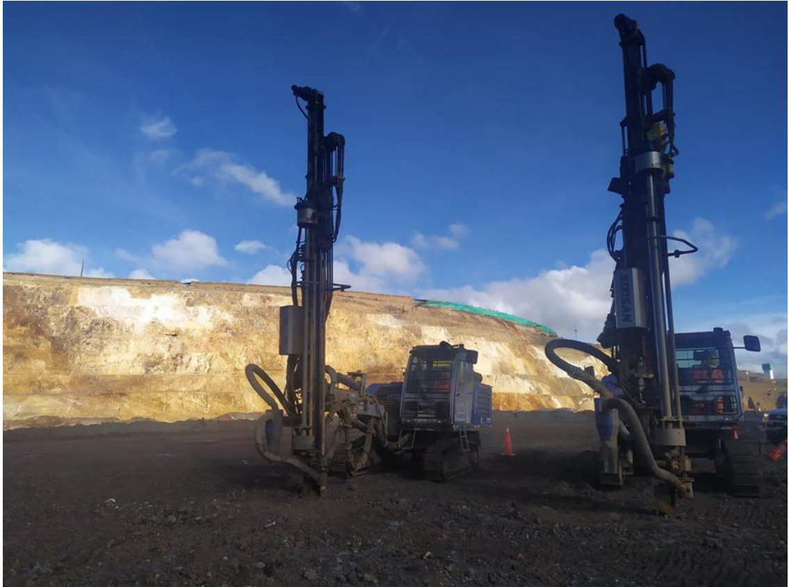
FOTOGRAFIA 4: Perforadora blast hole
