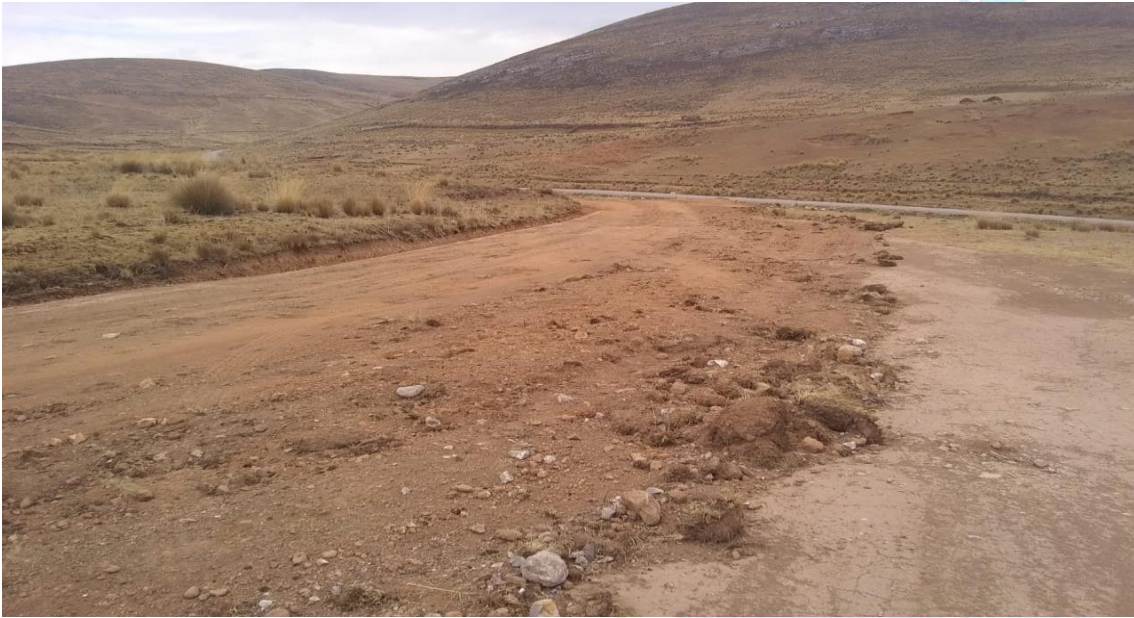
Fotografía N°3: OBSERVAMOS LA PARTE FINAL DEL PROYECTO CON EL CRUCE DE LA CARRETERA REGIONAL
