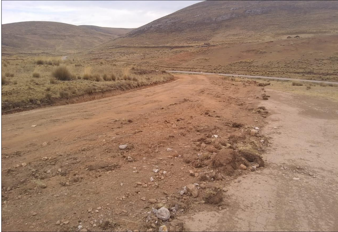
FOTOGRAFÍA N°01: SE OBSERVA EL CRUCE DE LA CARRETERA REGIONAL CON LA TROCHA DEL PROYECTO CERCA A LA LOCALIDAD DE PACCHA
