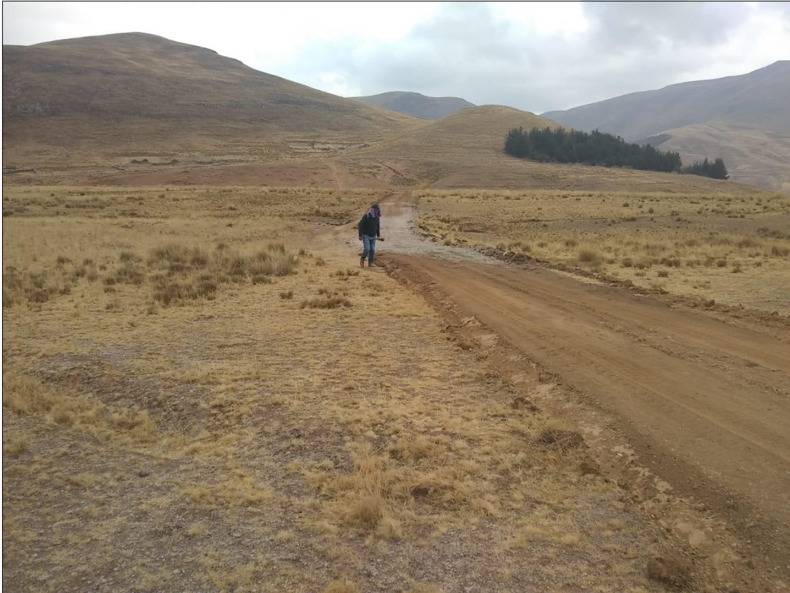
FOTOGRAFÍA N°03: EQUIPO TECNICO, TRAZANDO UNO DE LOS BADENES DEL PROYECTO
