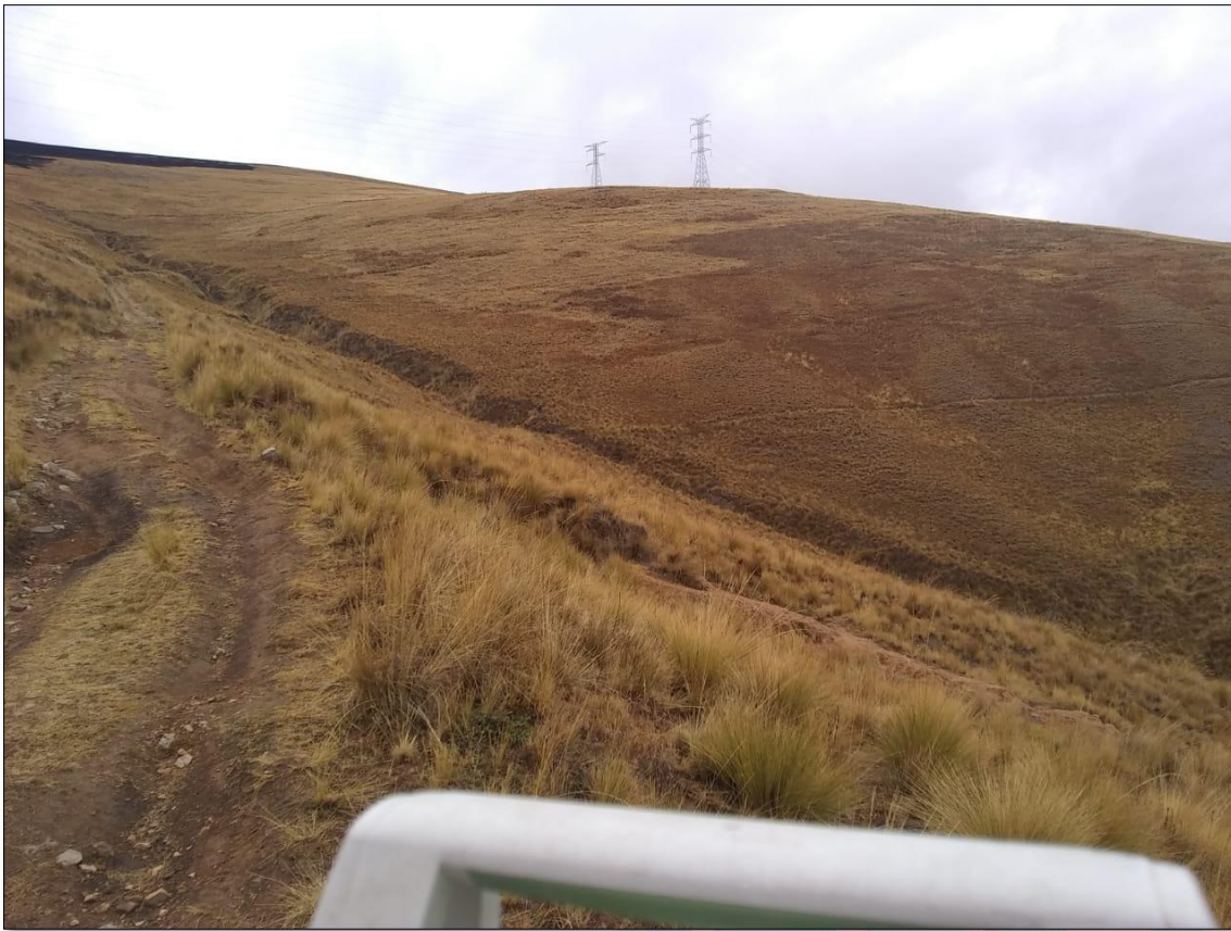
FOTOGRAFÍA N°07: SE OBSERVA LA PENDIENTE PRONUNCIADA DE LA TROCHA EXISTENTE, LA CUAL NO CIRCULAN SALVO CAMIONETAS DE DOBLE TRACCION ( 4X4) QUE SON APTAS PARA ESAS PENDIENTES.
