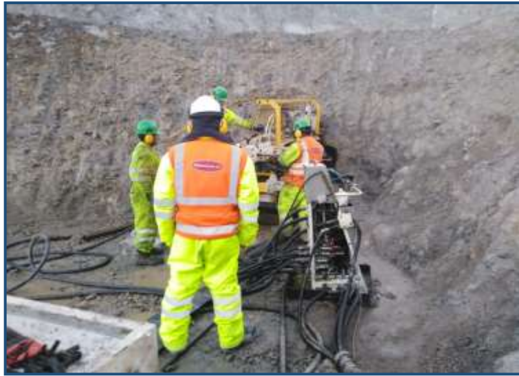
Imagen N° 21 Perforación de pozo.
