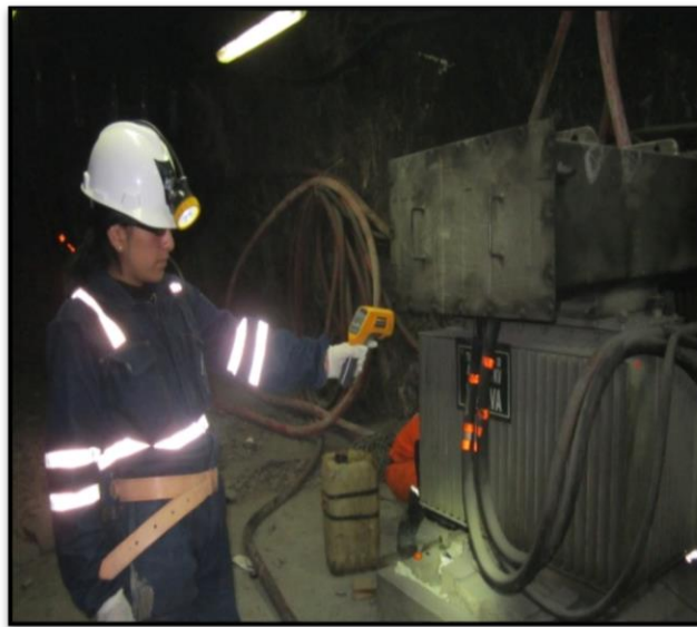
Fotografía N°03. Verificación de la limpieza y cierre correcto de las válvulas
