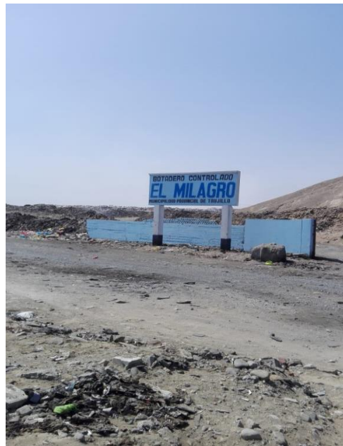
Foto N° 6 entrada del botadero el milagro
