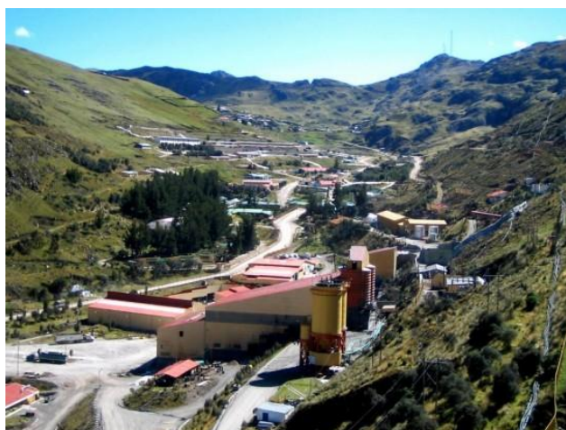
Ilustración 1. VISTA PANORAMICA DE LA CIA. MINERA MILPO – UND. EL PORVENIR.
