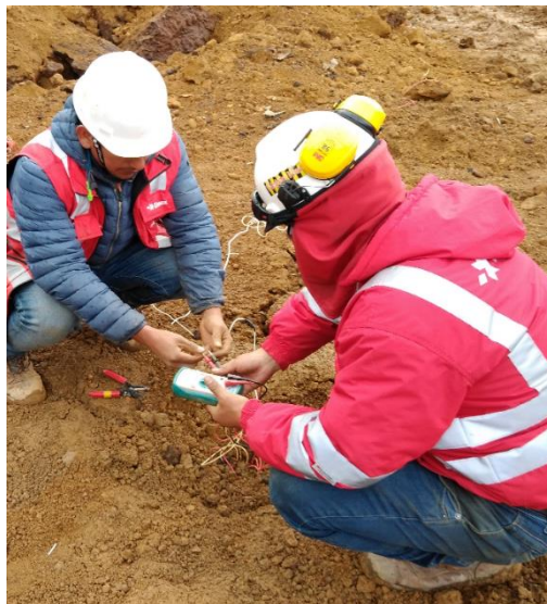
Figura 4. 11 Test de continuidad de cargas
