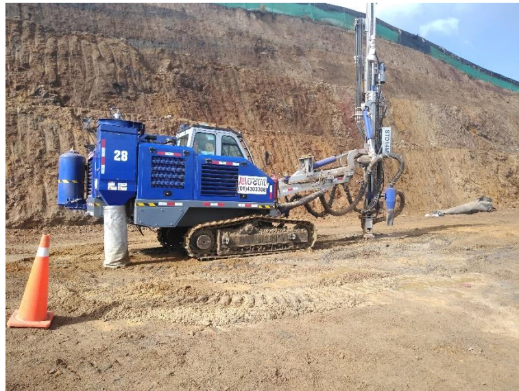
Figura 4. 6 Equipo de perforación SOOSAN
