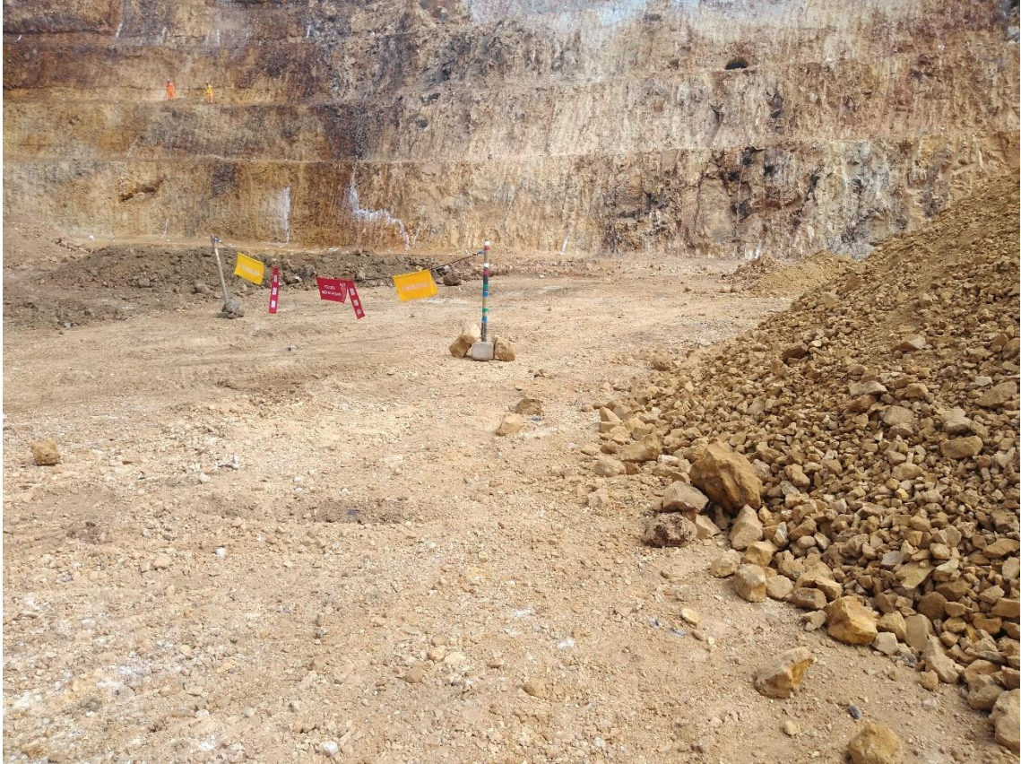
Figura 4. 26 Control de daño al talud
