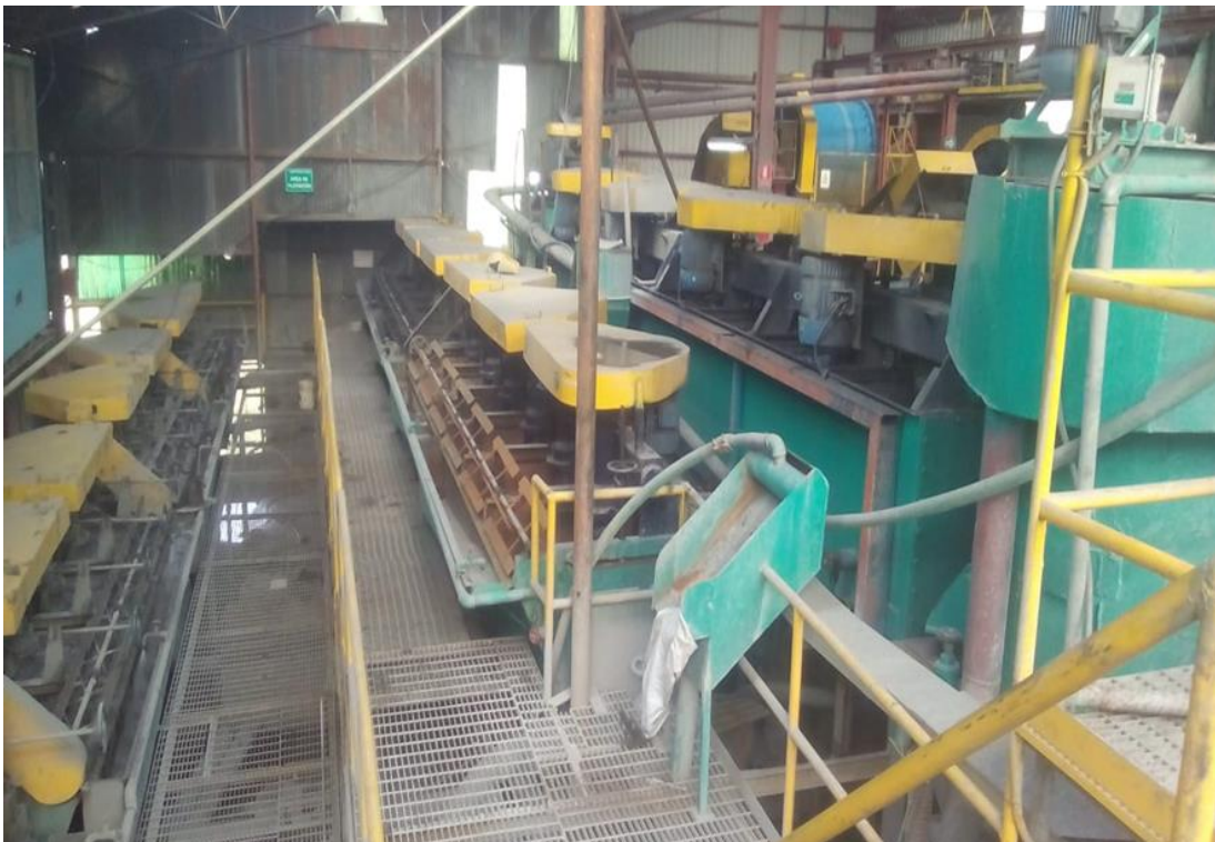
Imagen 4: Vista sureste del área de flotación de la Planta Concentradora
