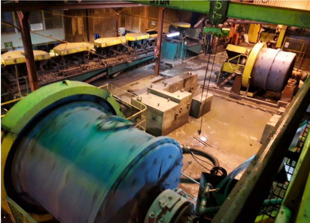
Imagen 1: Vista noreste de la Planta Concentrado Recuperada
