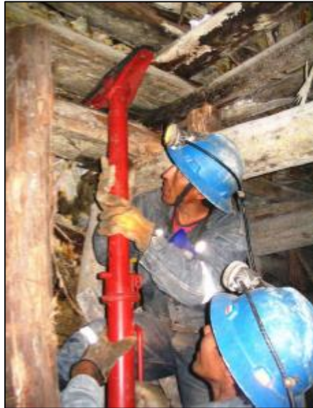
Ilustración 13. Instalación de las gatas mecánicas en cuadros.
