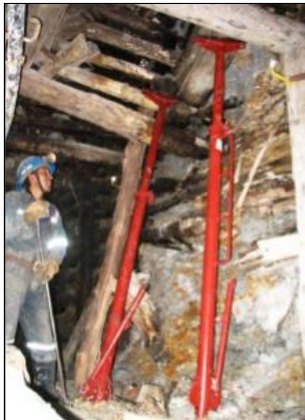
Ilustración 14. Instalación de las gatas mecánicas en cuadros.
