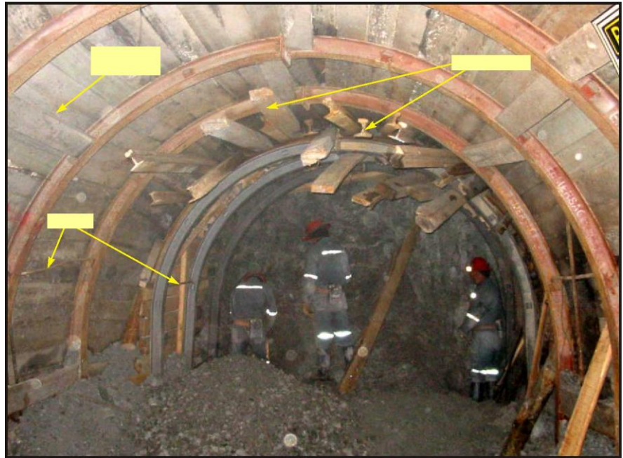
Ilustración 16. Instalación de las cimbras
