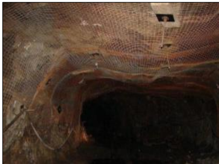
Ilustración 18. Malla electrosoldada (traslape)
