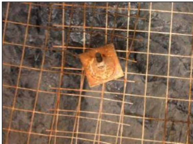
Ilustración 18. Malla electrosoldada (traslape)
