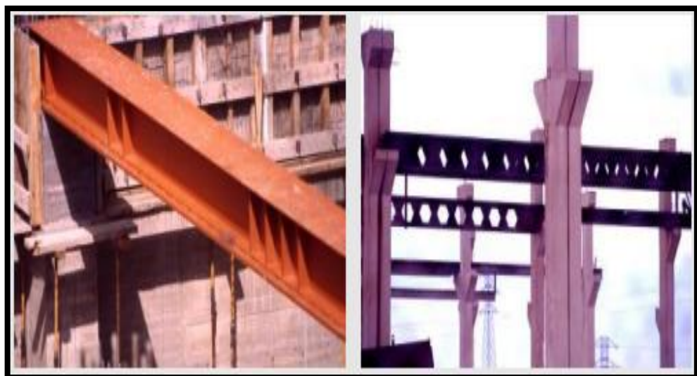
Figura N° 2.18: Unión de perfiles
