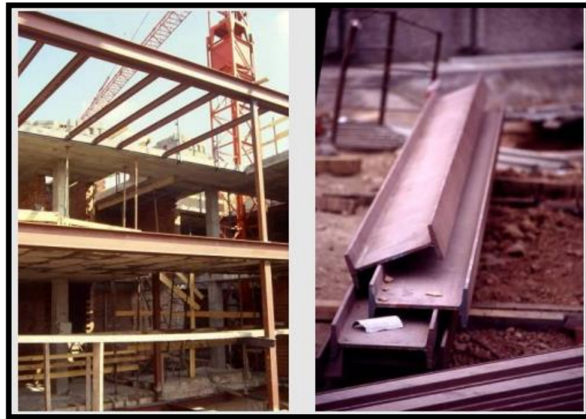
Figura N° 2.17: Unión de perfiles en una estructura
