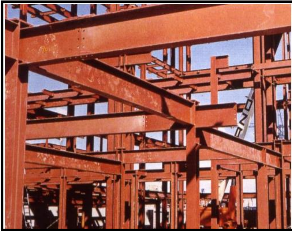
Figura N° 2.25: Armado de perfiles para una estructura
