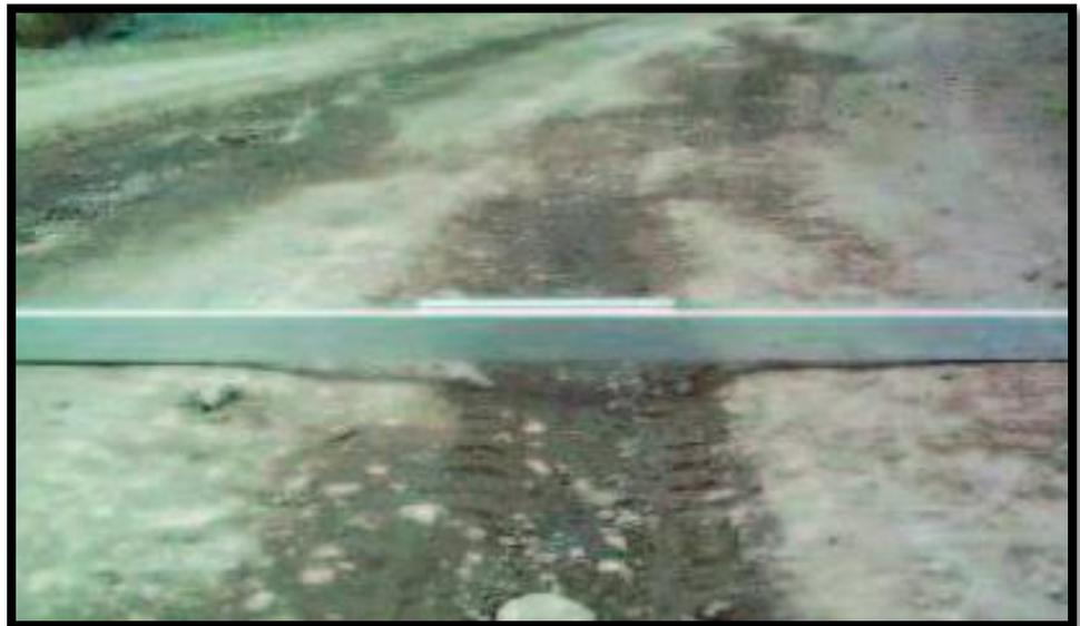
*Figura 7: Erosión, Gravedad 2: Profundidad entre 5 cm y 10 cm*
