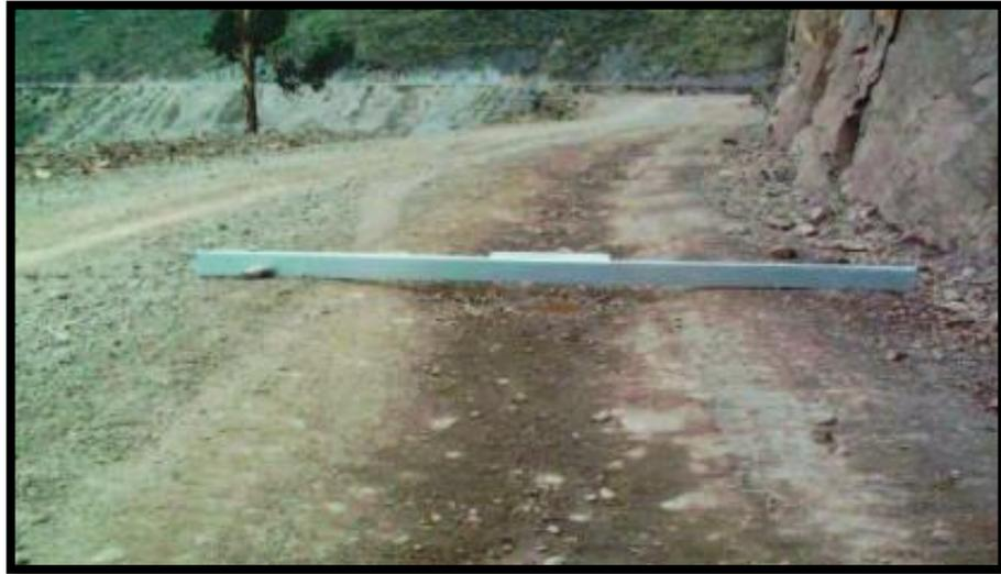
*Figura 5: Deformación, Gravedad 3: Huella/ hundimiento mayor a 10 cm.*
