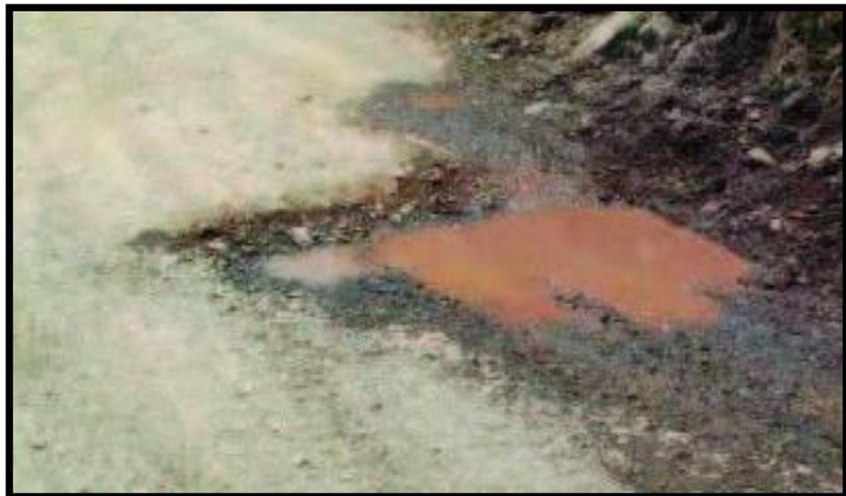
*Figura 9: Baches (Huecos), Gravedad 1: Pueden repararse por mantenimiento*
