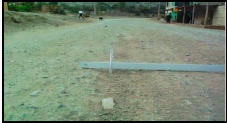
*Figura 3: Deformación, Gravedad 1: Huella/ hundimiento sensible al usuario, pero  $< 5$  cm.*
