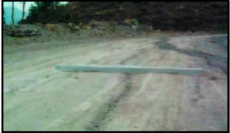
*Figura 6: Erosión, Gravedad 1: Sensible al usuario, pero  $< 5$  cm*
