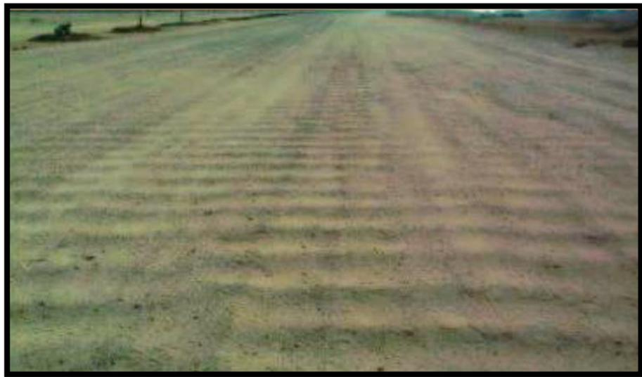
*Figura 12: Encalaminado, Gravedad 1: Sensible al usuario, pero profundidad < 5 cm.
