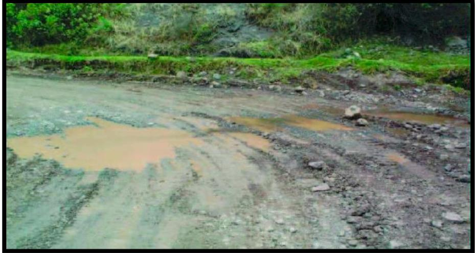
*Figura 13: Lodazal. Se percibe el estancamiento de aguas, debido a los baches y deformación de la vía.*
