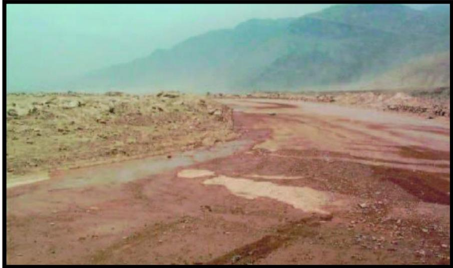
*Figura 10 : Baches (Huecos), Gravedad 2: Necesita una capa de material adicional
