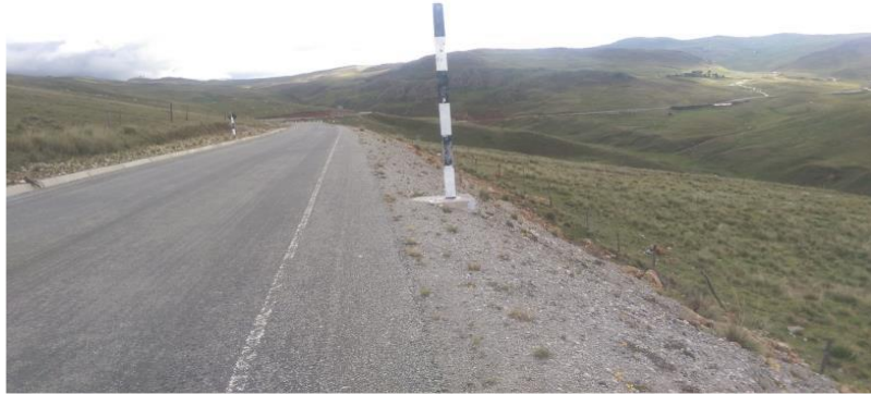
Figura 1: Pavimento Flexible de la vía en estudio
