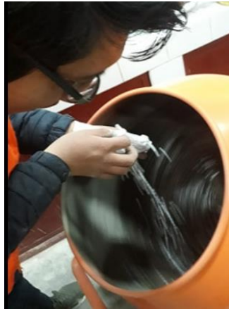
Ilustración 22: Aplicación en el concreto
