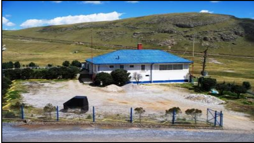
FOTO N° 1: VISTA DE LA PROPIEDAD DE COMPAÑÍA MINERA VOLCAN S.A.A. UBICADO EN LA ZONA DE GOLF
