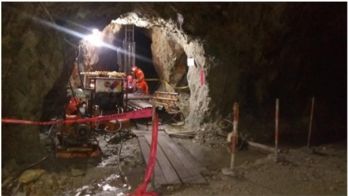
Fotografía 6: La fotografía muestra la perforación dinámica realizada en el nivel 200 del sondaje AMP-02
