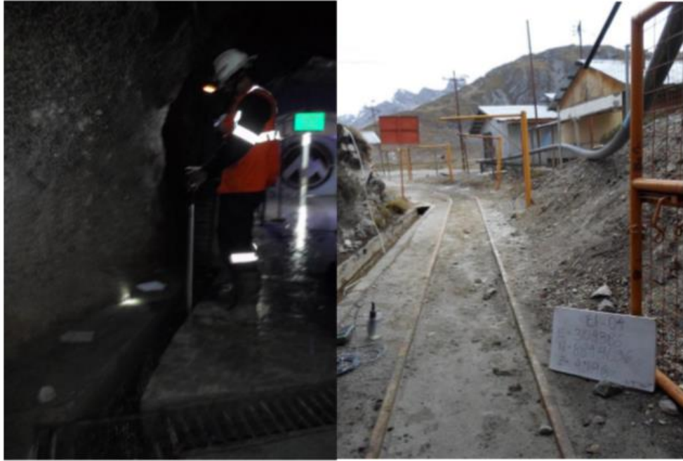
Fotografía 5: La fotografía de la izquierda y derecha ilustran las mediciones de caudal del nivel 200 la bocamina Hidro. Durante los trabajos de mapeo Hidrogeológico en el interior Mina.
