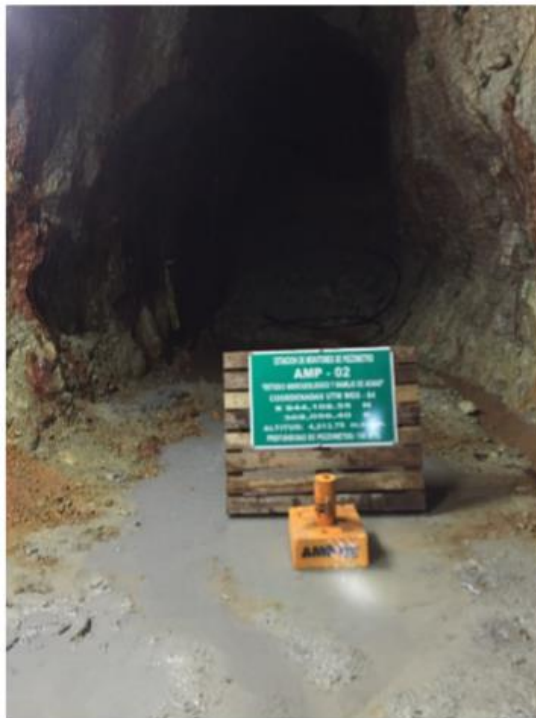
Fotografía 2: Piezómetro tipo Casagrande AMP-02, ubicado en el nivel 200, hacia el norte cerca al crucero 120 de interior mina.
