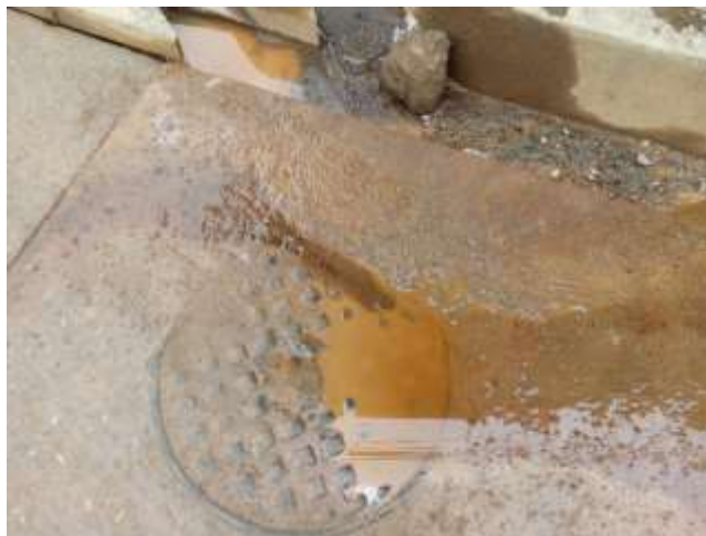
Obstrucción del sistema de drenaje y alcantarillado
