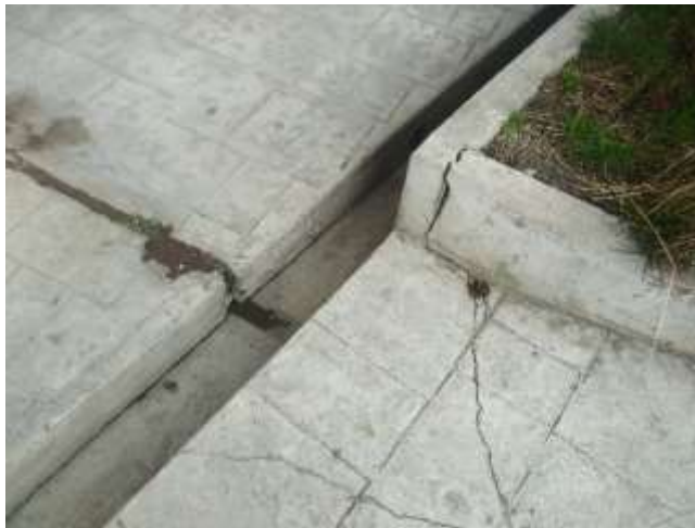
Obstrucción del sistema de drenaje y alcantarillado
