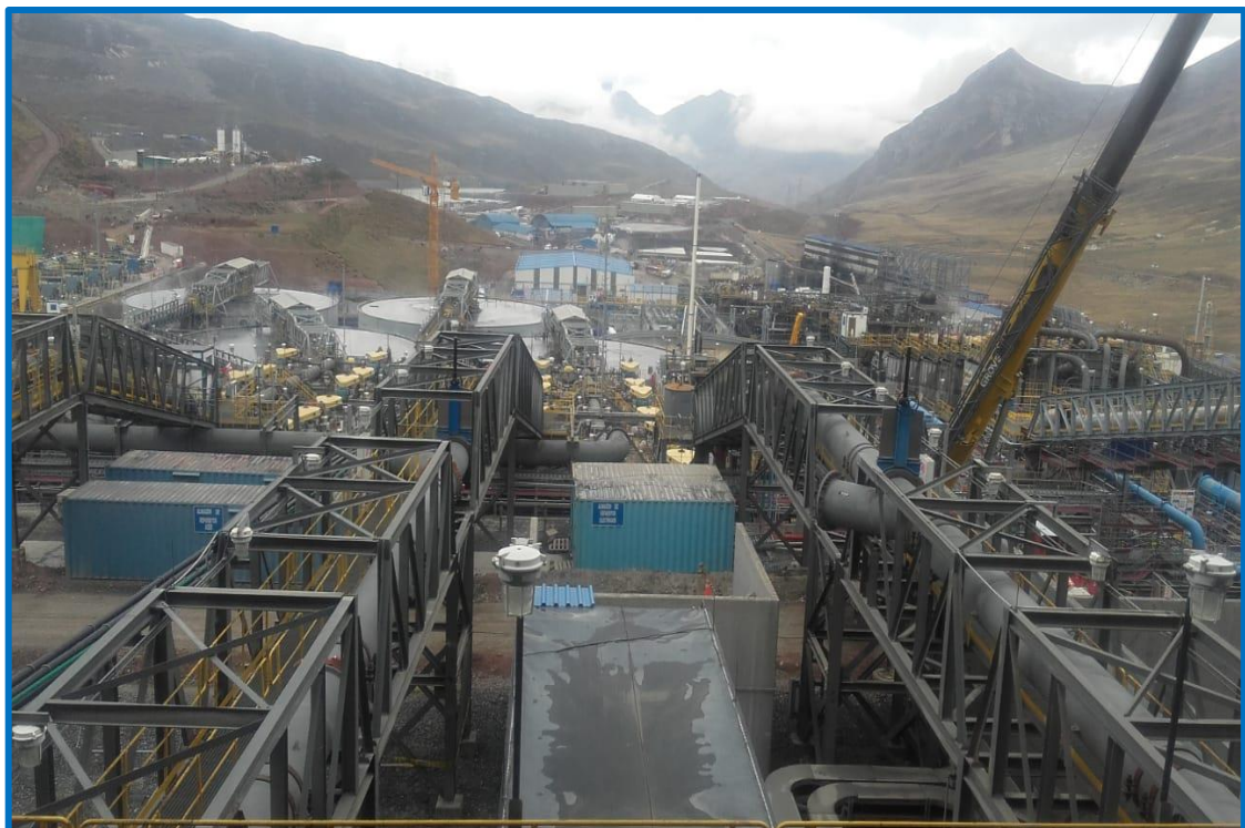
Anexo 23 – Vista panorámica del circuito de flotación y espesadores de relaves
