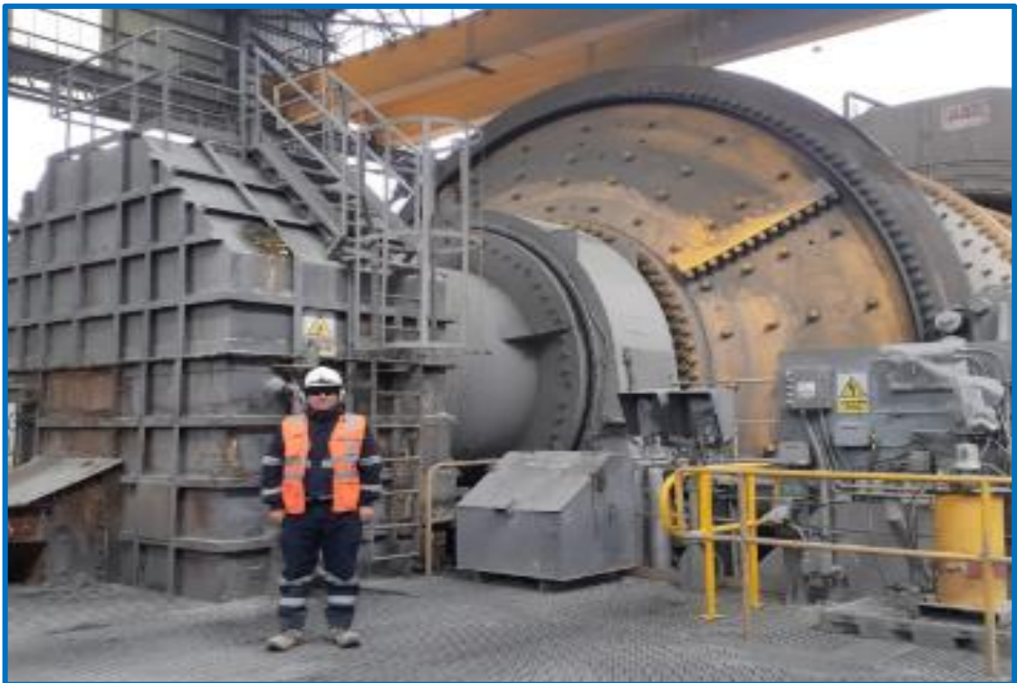
Anexo 21 – Cajón de descarga del molino de bolas.
