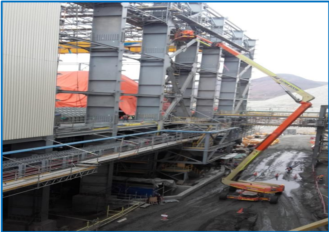
Anexo 16 – Construcción del circuito de molienda N°2.
