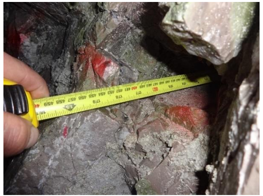
Medicion de longitud de taladros 4.50m
