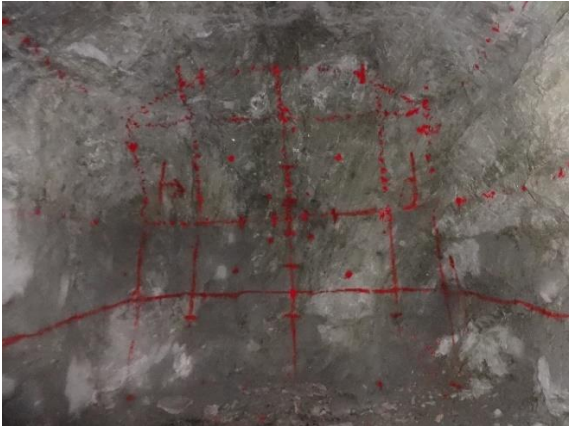
Pintado de colas para el control de paralelismo modelo matematico de Holmberg ajustado
