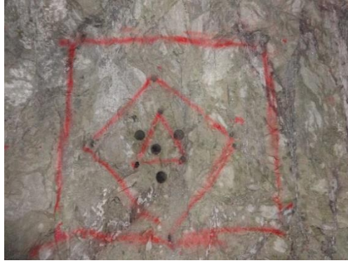
Figura: 71 Taladros perforados de acuerdo al diseño.
