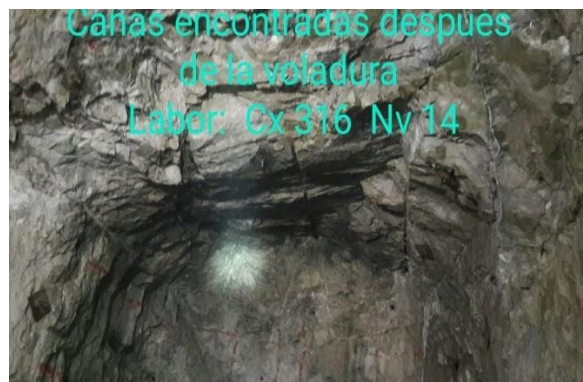
Resultado de la voladura con Barra de 16 pies, primera etapa de prueba avance 4.10 m
