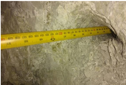
Figura: 58 Tacos de 1.20m después de la voladura.
