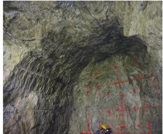
Resultado de la primera voladura con
