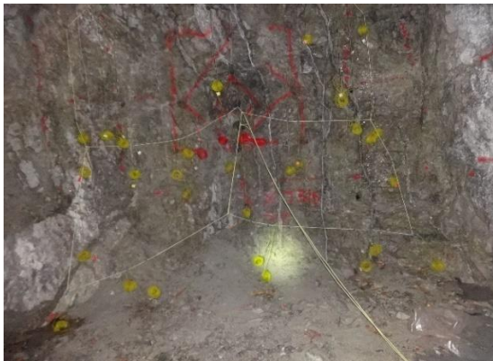
Primera etapa prueba carguio con fanel de 12 m
