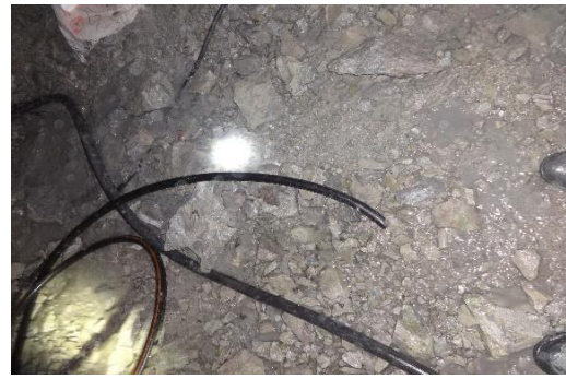
Figura: 57 Manguera de carguío sin marcar.
