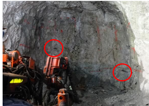
Figura: 56 No se usa los tres guidores.
