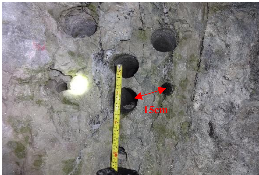
Figura: 55 Taladros del arranque al alivio a 15cm.
