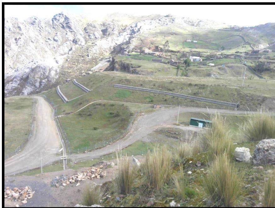
Imagen N° 02: Vista de la remediación de Azalía parte baja
