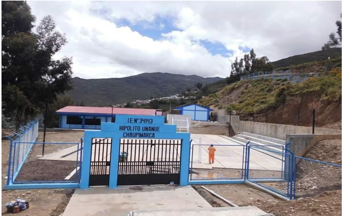
Instalaciones de la infraestructura de la I.E. N° 34143.
