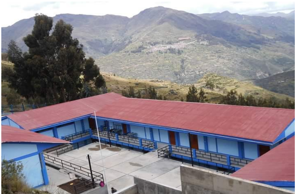
Nueva infraestructura de la I.E. N° 34143
