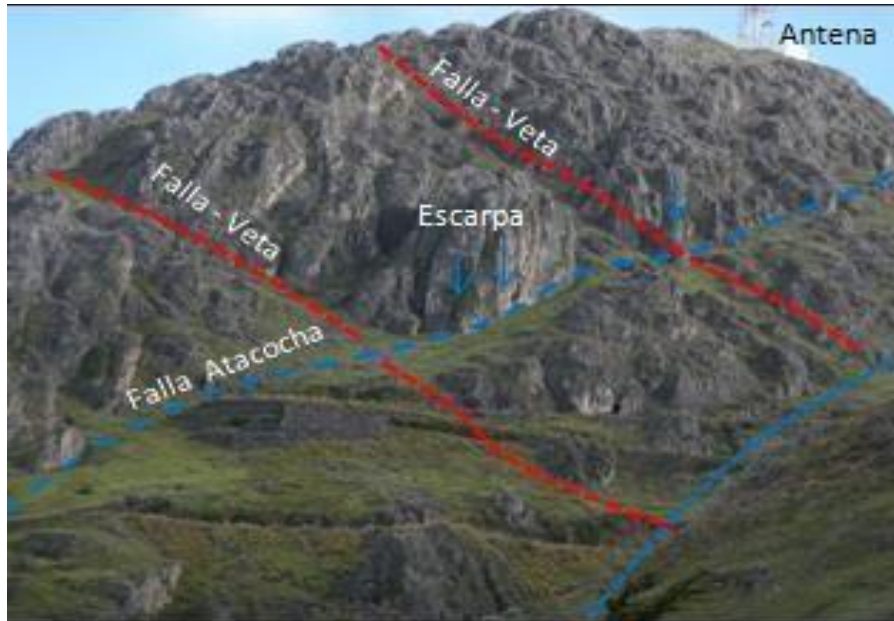
Ilustración 3: Escarpa de la falla atacocha intersectando con las Fallas de Veta
