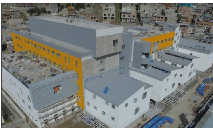
Ilustración 34. Imagen de la obra - Muestra 4.
