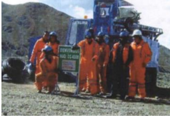
Figura 16 - Equipo de perforación
